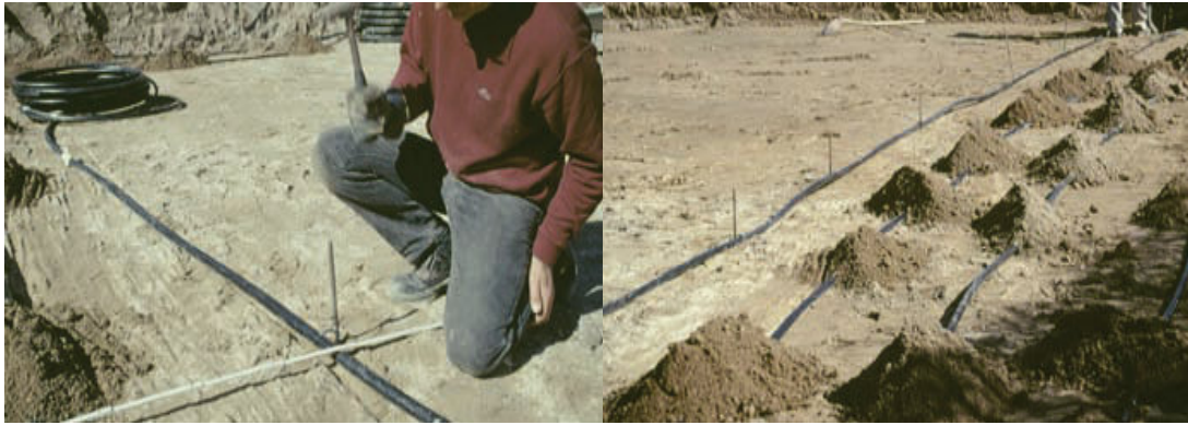
Εικόνες 6.19 Ευθυγράμμιση των σωληνώσεων με ράμια και στερέωση στους με χώμα ή άμμο.
