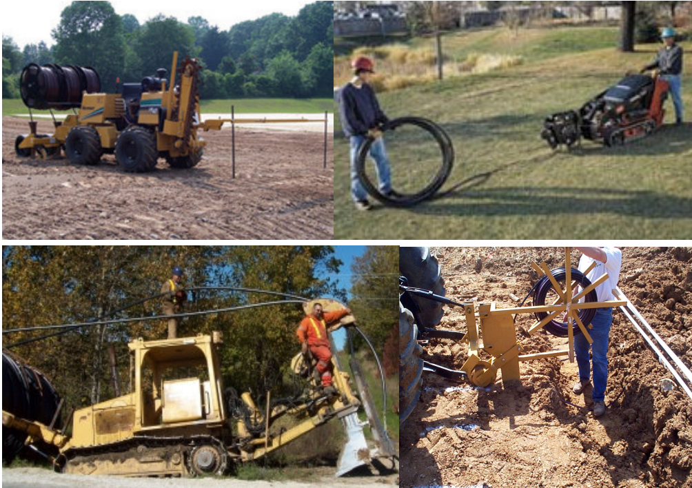
Εικόνες 6.11 Δομητικά άροτρα κατά την εκτέλεση εργασιών στους χώρους εγκατάστασης του γεωεναλλάκτη.
