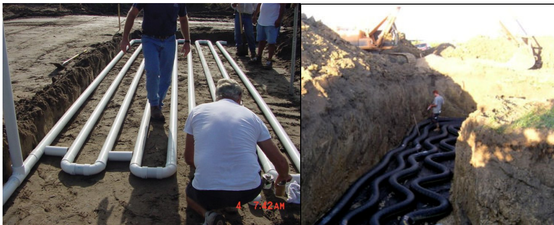
Εικόνες 4.3.2 Γεωεναλλάκτης αέρα-εδάφους κατά την φάση της εγκατάστασης του στο έδαφος.
