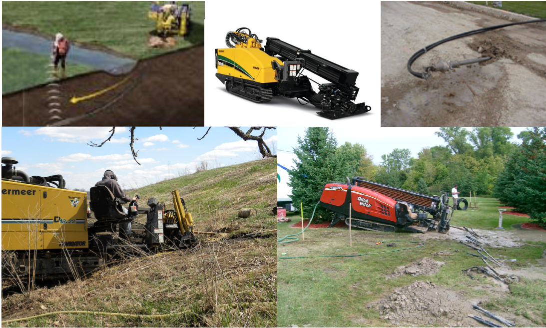
Εικόνες 6.14 Οριζόντιες μηχανές διατρήσεων για την εγκατάσταση γεωεναλλακτών οριζόντιας διάταξης.
