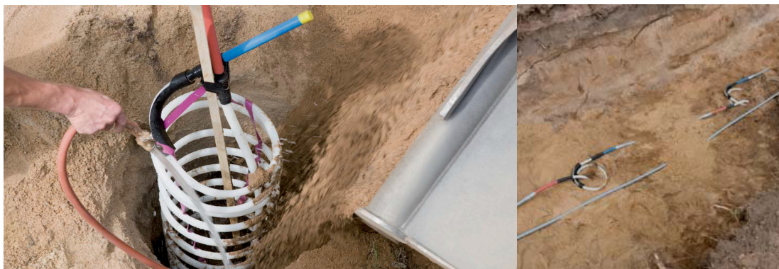
Εικόνες 4.4.1.3 Σπειροειδής διάταξη κατά την πλήρωση του με τα χώματα των εκσκαφών καθώς μετά το πέρας της εργασίας. (πηγή: Rehau)
