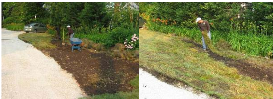
Εικόνες 6.24 Εγκατάσταση γεωεναλλακτών και αποκατάσταση τοπίου σε κατοικία στην Annapolis του Maryland, ΗΠΑ. (πηγή: http://www.earthrivergeo.com )
