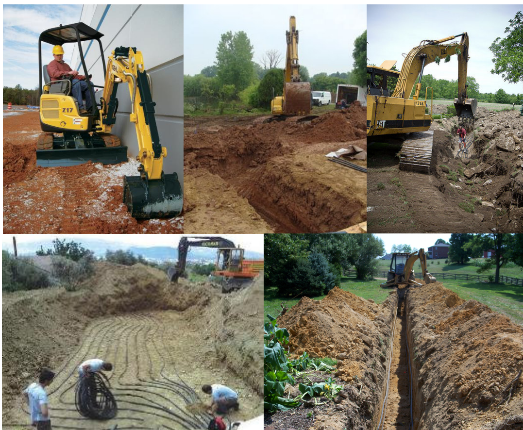
Εικόνες 6.12 Διάφορες εργασίες εκσκαφών. Επειδή ένας εκσκαφέας μπορεί να κάνει όλες τις εργασίες σε μια εγκατάσταση γεωεναλλακτών (ιδιαίτερα μικρού μεγέθους), θα μπορούσε να είναι το μόνο σκαπτικό μηχάνημα κατά τις απαιτούμενες εργασίες.
