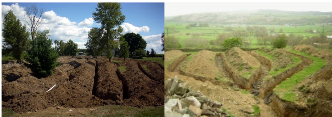
Εικόνες 4.4.2.1 Τοποθέτηση οριζόντιων δικτύων σωληνώσεων γεωεναλλακτών σε ορύγματα (εκσκαφές χαντακιών) στο έδαφος.
