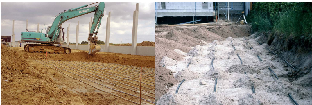
Εικόνα 6.20 Επιχωμάτωση με τα χώματα των εκσκαφών. Εικόνα 6.21 Επίστρωση με στρώμα άμμου και μετά επιχωμάτωση με τις εκσκαφές.
