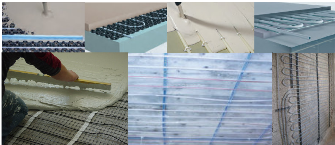
Εικόνες 5.2.2.1 Κατασκευή ενδοδαπέδιων, ενδοτοιχίων και συστήματα «υγρού» τύπου οροφής για θέρμανση και ψύξη.
