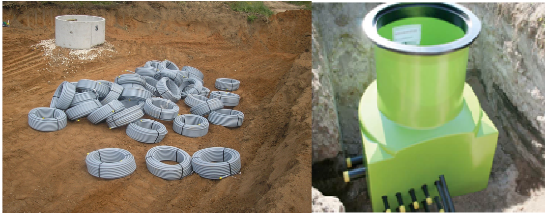
Εικόνες 6.15 Δύο τύποι κιβωτίων σύνδεσης, από σκυρόδεμα και πλαστικό. Εκεί μέσα θα συνδεθεί ο συλλέκτης με τους βρόχους του γεωεναλλάκτη.
