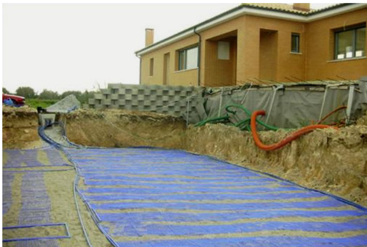
Εικόνα 4.4.2.1.7 Εγκατάσταση σωληνώσεων σε οριζόντιο σύστημα Γ.Α.Θ. με πλέγμα, στη Θεσσαλονίκη.
