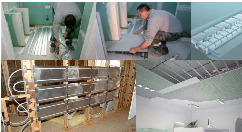
Εικόνες 5.2.1.1 Συστήματα θέρμανσης και ψύξης ξηράς δόμησης.
