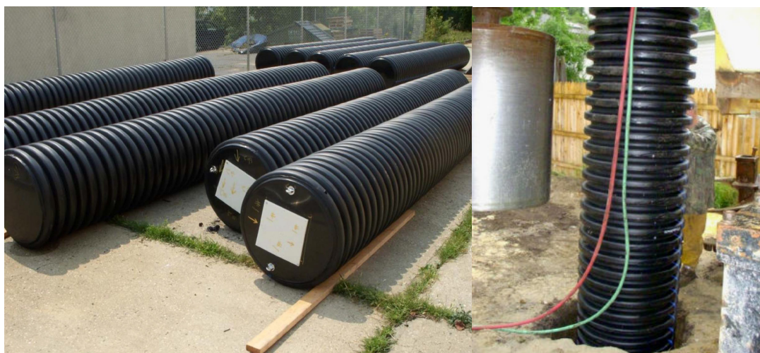
Εικόνες 4.6.2 Στήλες GeoColumn σε εμπορική μορφή κατά την τοποθέτησή τους στο χώρο του οικοπέδου.
