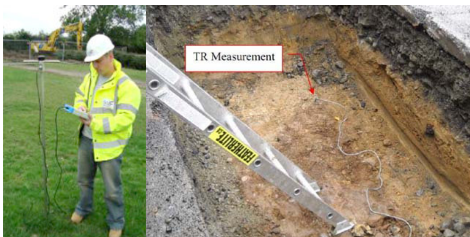
Εικόνες 6.4 Μέτρηση εδαφικής θερμικής αγωγιμότητας. Εικόνα Μέτρηση εδαφικής θερμικής αντίστασης.
