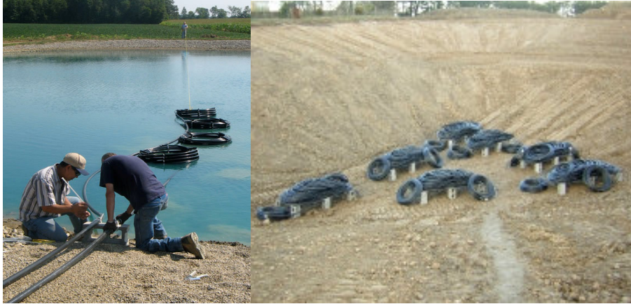
Εικόνες 4.4.3.1 Καταβυθισμένα κλειστά κυκλώματα εναλλακτών Γ.Α.Θ. σε ήδη υπάρχοντα επιφανειακά νερά ή σε τεχνητούς λάκκους.
