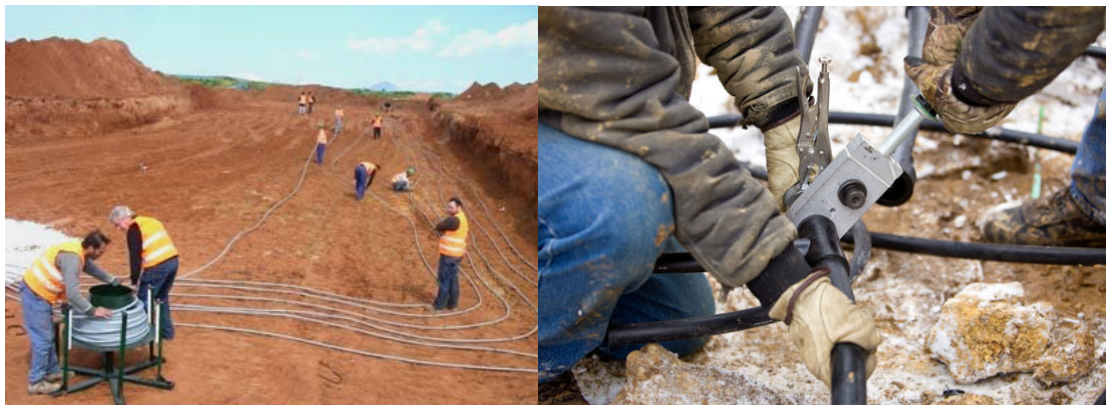
Εικόνα 6.17 Τοποθέτηση σωληνώσεων οριζόντιου γεωεναλλάκτη σε μεγάλο μεγέθους εγκατάσταση. Εικόνα 6.18 Θερμοκόλληση σωληνώσεων στο χώρο του εργοταξίου, με κατάλληλο εργαλείο.
