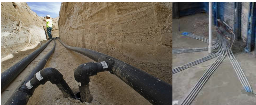
Εικόνες 4.4.1.1 Κάθετη διάταξη κλειστού κυκλώματος γεωεναλλάκτη. Και κάτω, λεπτομέρειες από εγκαταστάσεις κάθετων γεωεναλλακτών.
