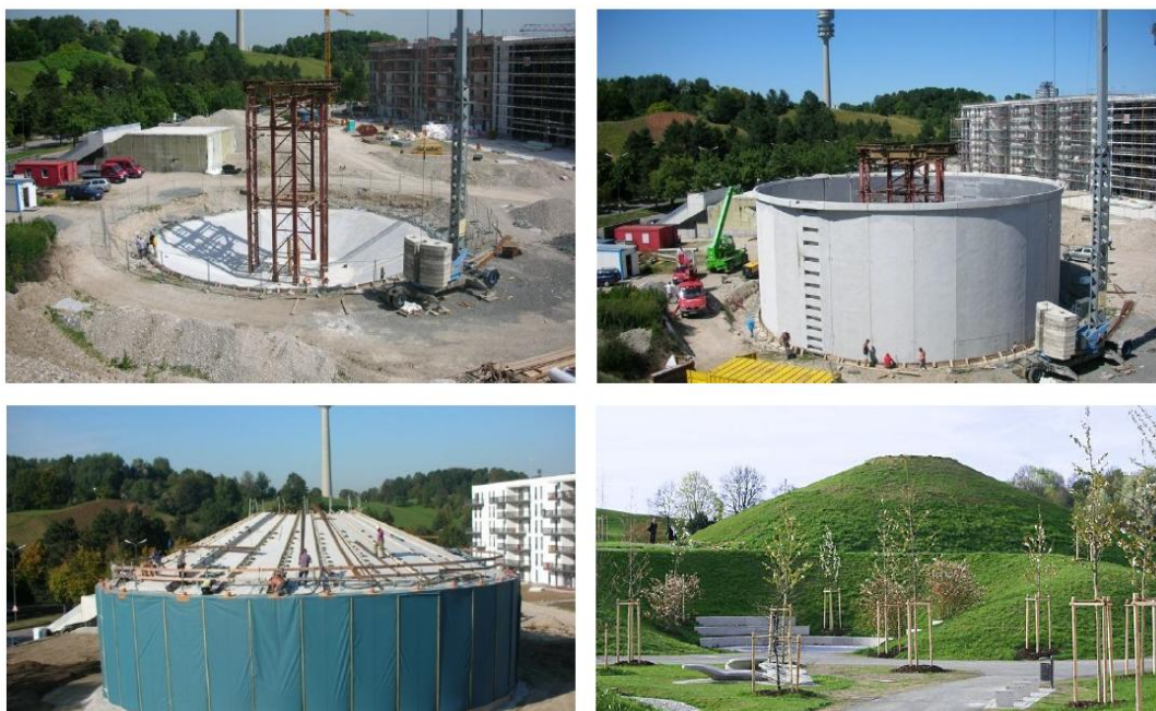
Κατασκευή δεξαμενής εποχιακής αποθήκευσης 5700 m 3 στο Μόναχο Γερμανίας έτος 2007
