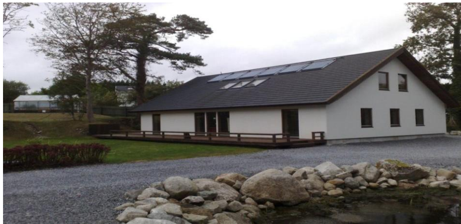
Σπίτι με ηλιακούς συλλέκτες και εποχιακή δεξαμενή θερμικής ενέργειας
