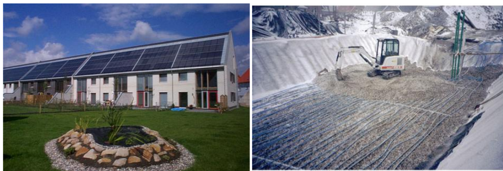
Αριστερά τα κτίρια με τους ηλιακούς συλλέκτες στην κεκλιμένη οροφή ,δεξιά η αποθήκη σε λάκκο κατά την κατασκευή ,Steinfurt 1998
