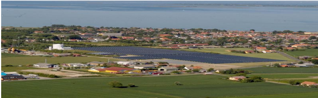
Marstal ΕΠΟΧΙΑΚΗ ΑΠΟΘΗΚΕΥΣΗ ΘΕΡΜΙΚΗΣ ΕΝΕΡΓΕΙΑΣ ΣΕ ΛΑΚΚΟ –ΚΟΙΛΩΜΑ
