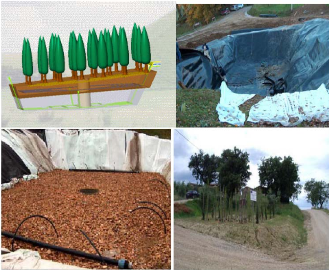
Απεικόνιση της τεχνολογίας υπεδάφιας διάθεση υγρών αποβλήτων ελαιοτριβείου με το σύστημα OLEICO (με πλήρη προστασία του υδροφορέα).
