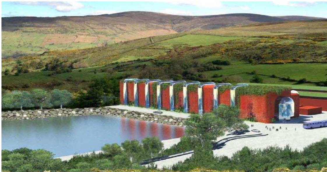
Εικόνα 3.5 : Υδροληψία και σταθμός παραγωγής του Spirit of Ireland
