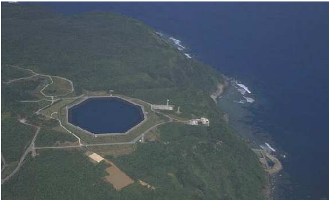
Εικόνα 3.1: Αεροφωτογραφία του έργου. Διακρίνεται η υδροληψία, ο άνω ταμιευτήρας και οι οδοί προσπέλασης
