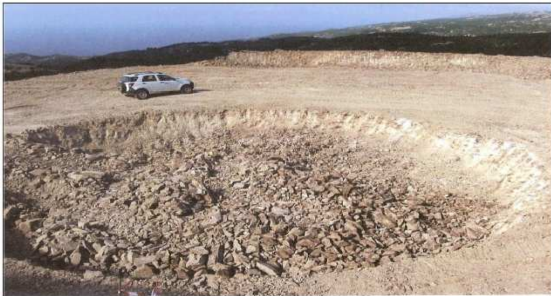
Εικόνα 3.12: Εκσκαφή θεμελίου ανεμογεννήτριας
