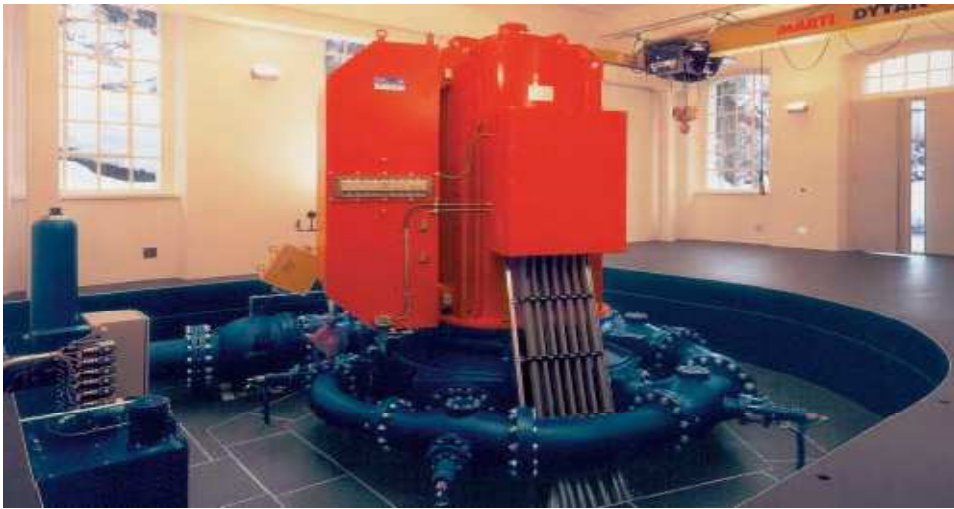
Εικόνα 4.7: Υδροστρόβιλος Adritz Pelton
