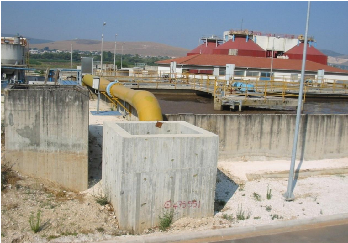
11. ΑΓΩΓΟΣ ΑΝΑΚΥΚΛΟΦΟΡΙΑΣ ΠΟΥ ΜΕΤΑΦΕΡΕΙ ΛΥΜΑΤΑ ΑΠΟ ΤΟΝ ΒΙΟΑΝΤΙΔΡΑΣΤΗΡΑ ΣΤΗΝ ΠΡΟ ΑΝΟΞΙΚΗ ΔΕΞΑΜΕΝΗ
