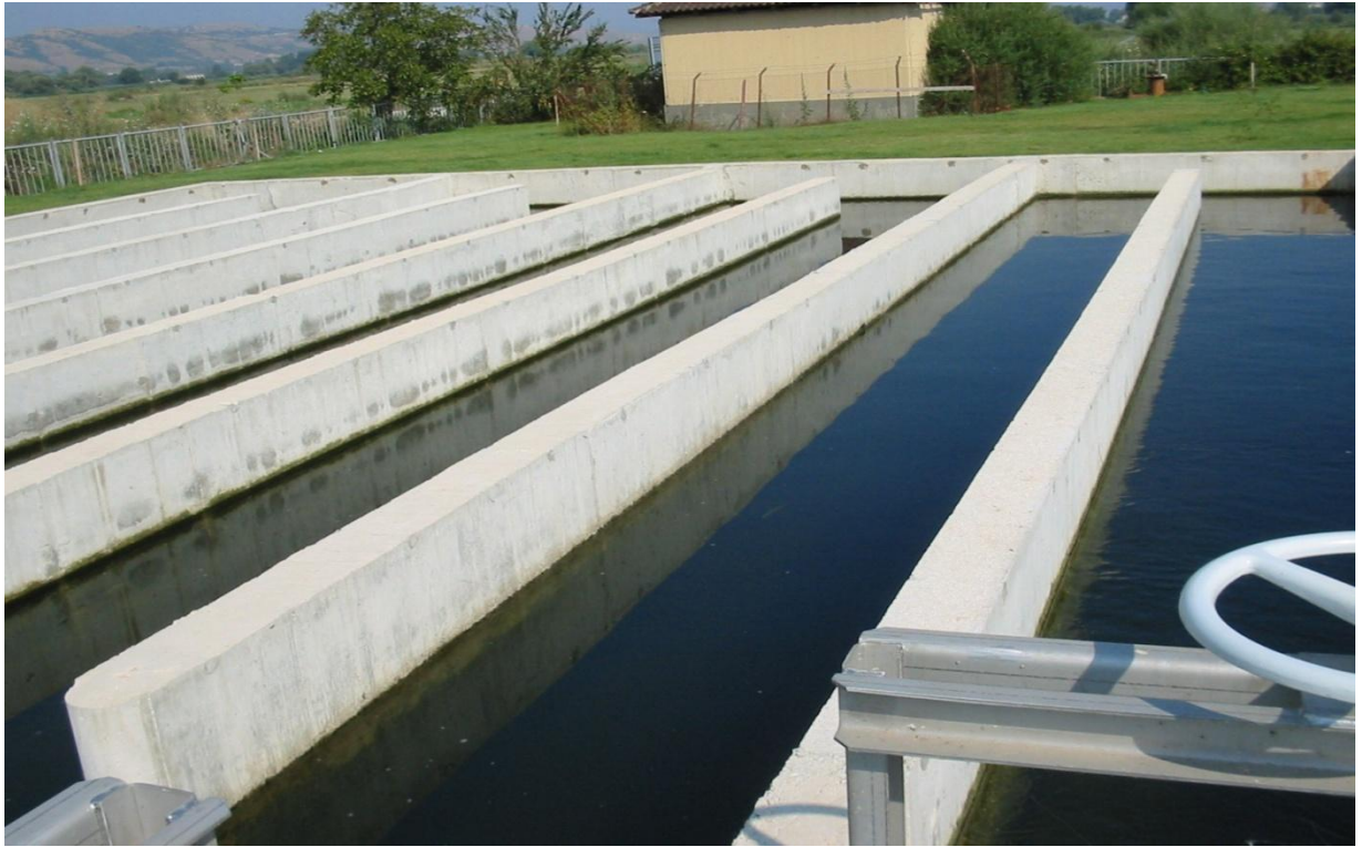
17. ΔΕΞΑΜΕΝΗ ΧΛΩΡΙΩΣΗ ΜΕ ΕΜΦΑΝΗ ΤΑ ΘΥΡΟΦΡΑΓΜΑΤΑ
