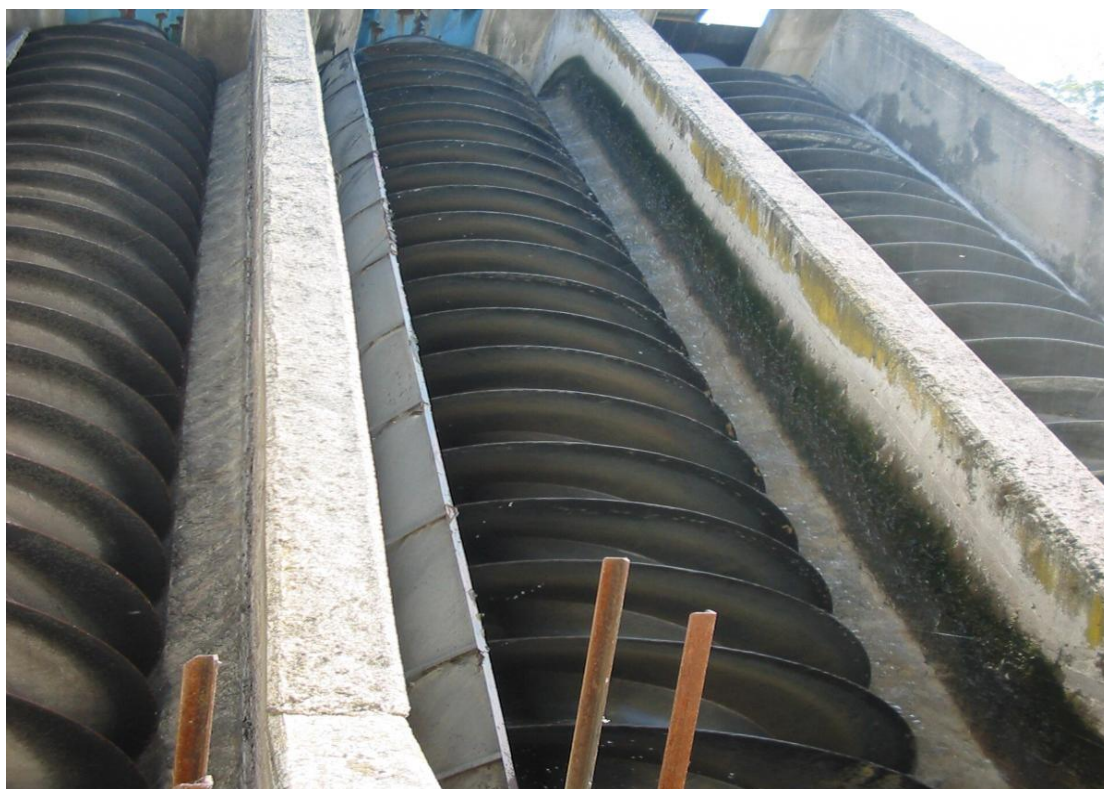
9.ΚΟΧΛΙΕΣ ΑΝΥΨΩΣΗΣ ΛΥΜΑΤΩΝ ΠΡΟΣ ΔΕΞΑΜΕΝΕΣ ΠΡΩΤΟΒΑΘΜΙΑΣ ΚΑΘΙΖΗΣΗΣ
