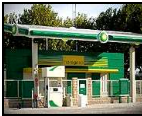
Εικόνα 4.2: Σταθμός διανομής καυσίμου της BP στη Βαρκελώνη της Ισπανίας, για τον ανεφοδιασμό τριών δημόσιων λεωφορείων που κινούνται με κυψέλες καυσίμου.
