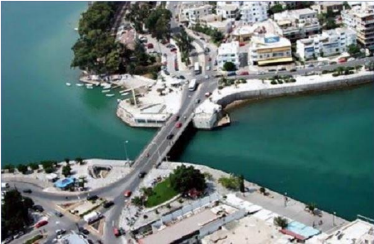
Εικόνα 1: Πορθμόςτου Ευρίπου (Παλαιά γέφυρα)
