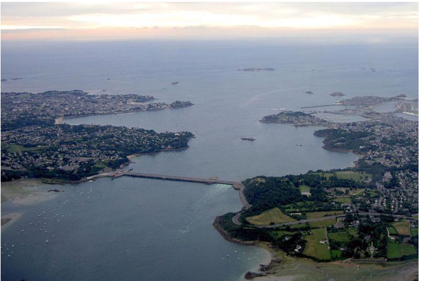
Εικόνα 2.2: Εγκατάσταση La Rance, Γαλλία
