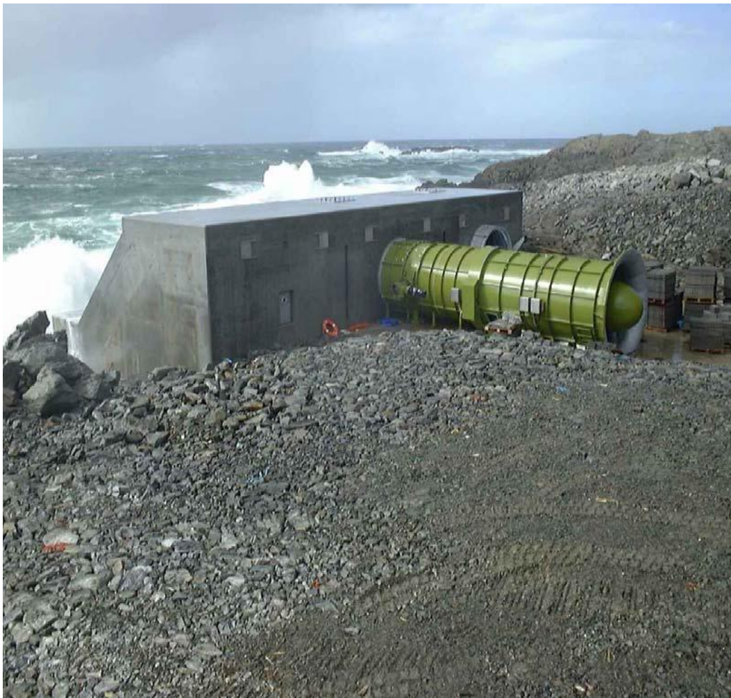
Εικόνα 4.2: Η ολοκληρωμένη εγκατάσταση παραγωγής ηλεκτρικής ενέργειας LIMPET
