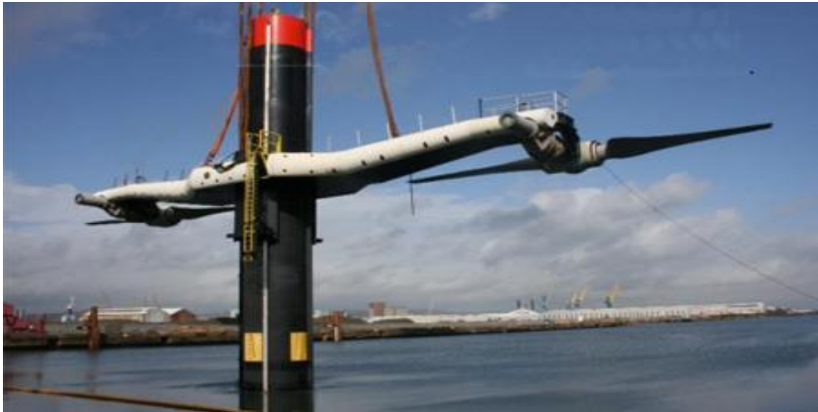
Εικόνα 3.3: Η γεννήτρια Seagen κατά την εγκατάστασή της
