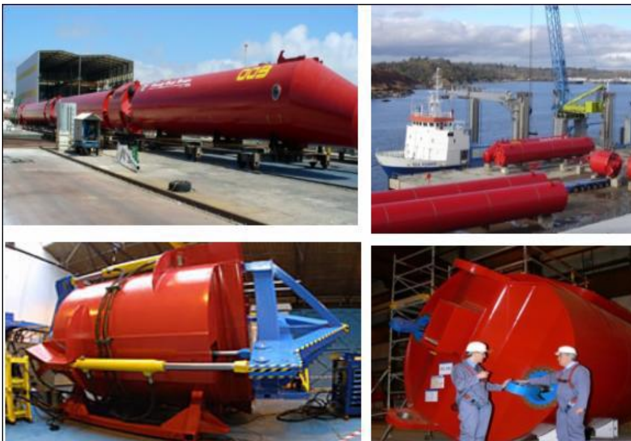
Εικόνα 4.35: Φωτογραφίες από τα διάφορα στάδια κατασκευής και μεταφοράς ενός μετατροπέα Pelamis συνολικής ισχύος 750kW.
