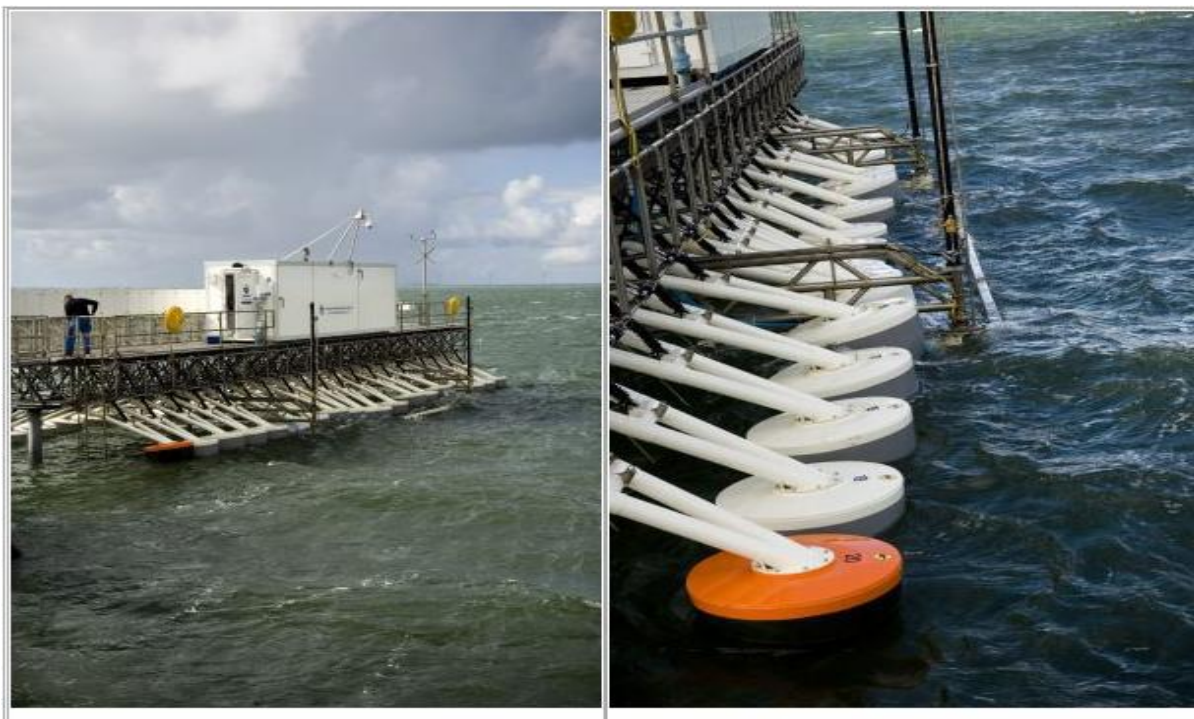
Εικόνα 4.22: Πλάγια όψη και μία από τις δύο σειρές σημαδούρων του μοντέλου Wave Star στο Nissum Bredning.
