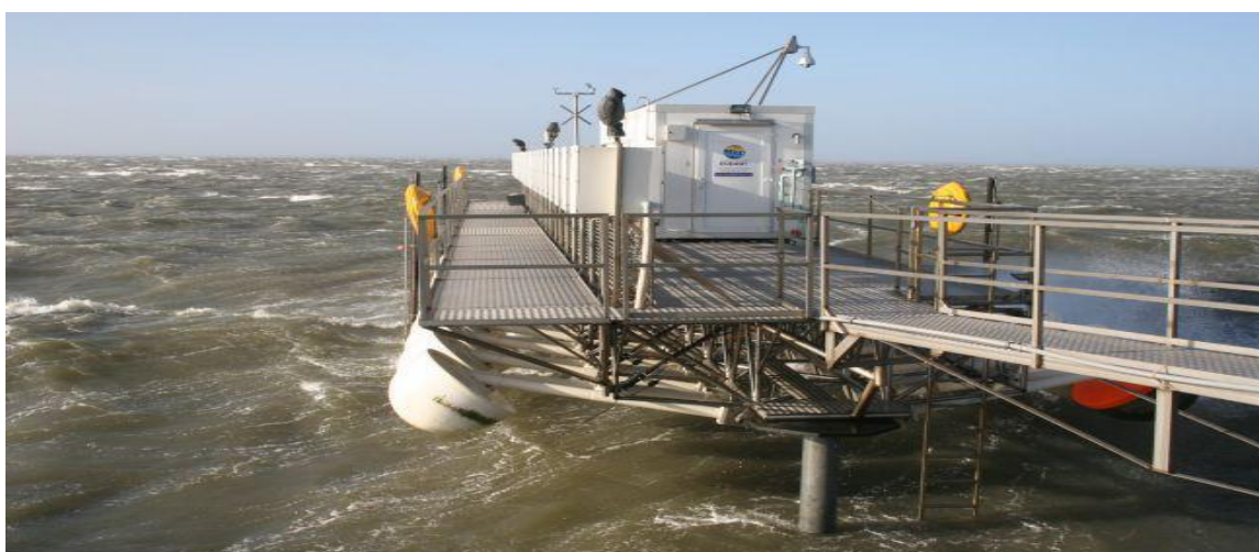
Εικόνα 4.21: Το μοντέλο Wave Star κλίμακας 1:10 στο Nissum Bredning της Δανίας. Διακρίνονται οι σημαδούρες σε ανυψωμένη θέση εκτός λειτουργίας.
