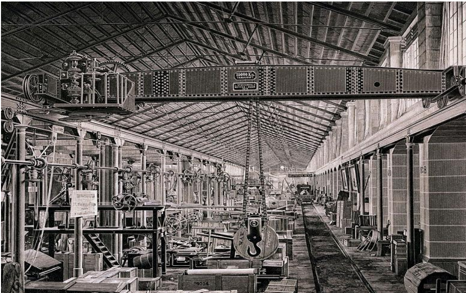
Εικόνα 3.1.1: Γερανογέφυρα ατμοκίνητη γερμανικής μελέτης και κατασκευής, του 1875
