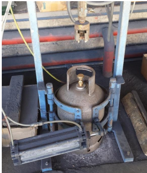
Εικόνα 53. Τοποθέτηση χειροκίνητης βαλβίδας στη φιάλη
