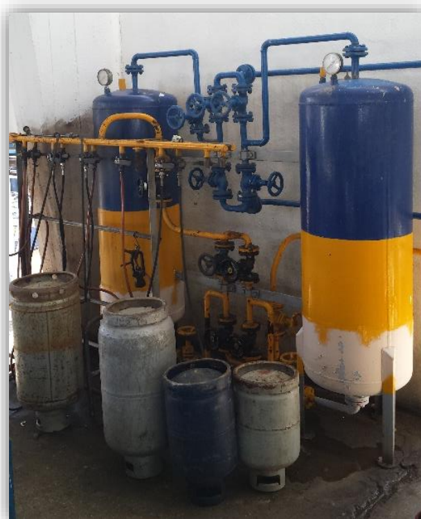
Εικόνα 50. Διάταξη εκκένωσης φιαλών
