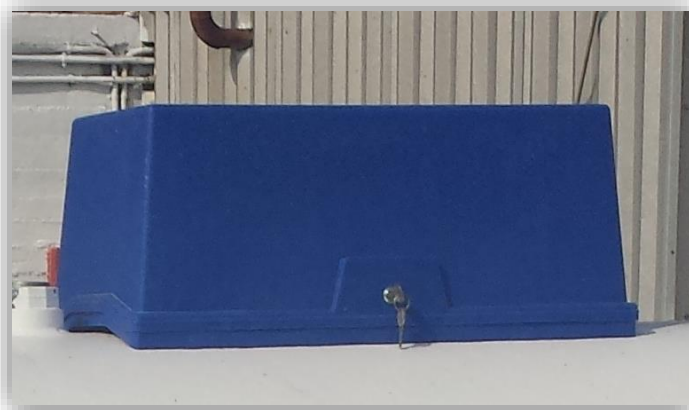
Εικόνα 48. Πλαστικό καπάκι εξαρτημάτων δεξαμενής
