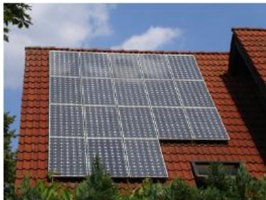
Εικόνα 12.5.A : Φ/Β σε κεραμοσκεπή
