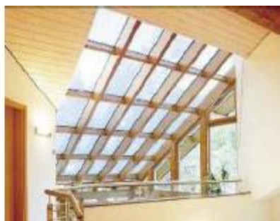
Εικόνες 12.5.Δ-Ε : Διάφανα Φ/Β πλαίσια στην οροφή κατοικίας
