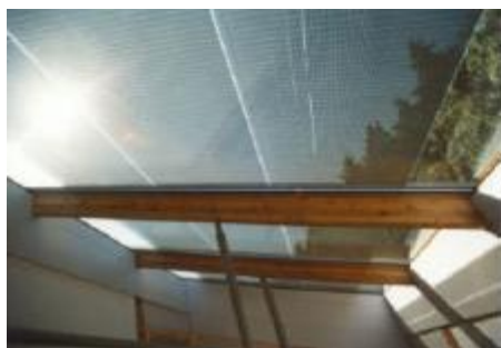
Εικόνες 12.5.Δ-Ε : Διάφανα Φ/Β πλαίσια στην οροφή κατοικίας
