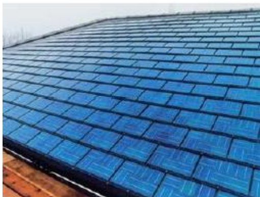
Εικόνα 12.5.B : Φ/Β ως κεραμίδια
