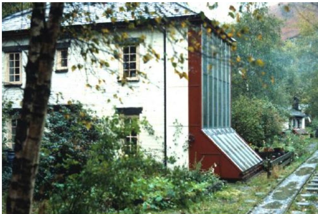
Εικόνα 4.5: Μεταγενέστερη επέμβαση εφαρμογής τοίχου Trombe σε μονοκατοικία
