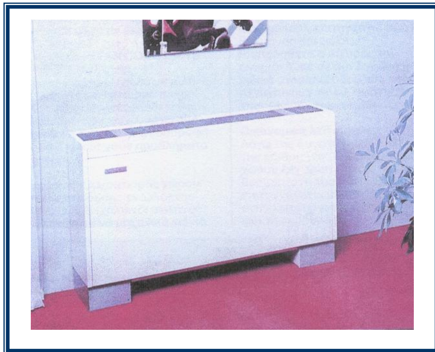
ΣΧΗΜΑ 5 Fan Coil δαπέδου (εμφανές) σε αίθουσα γραφείων.
