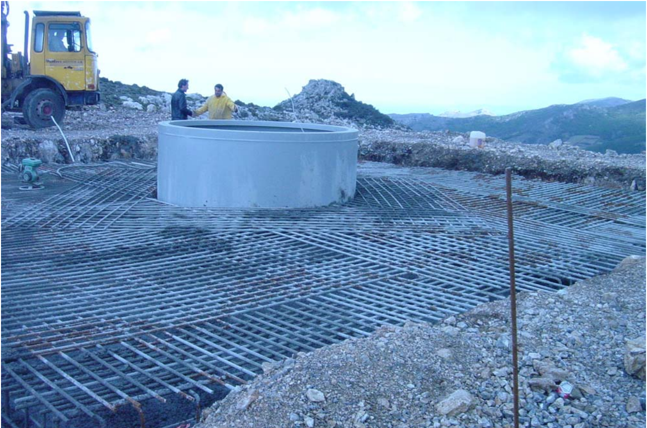
1. ΦΩΤΟΓΡΑΦΙΑ ΑΠΟ ΒΑΣΗ ΘΕΜΕΛΙΩΣΗΣ VESTAS V-52 (ΑΙΟΛΙΚΟ ΠΑΡΚΟ ΣΤΗ ΘΕΣΗ 'ΡΟΒΑΣ' Ν. ΧΑΝΙΩΝ)
