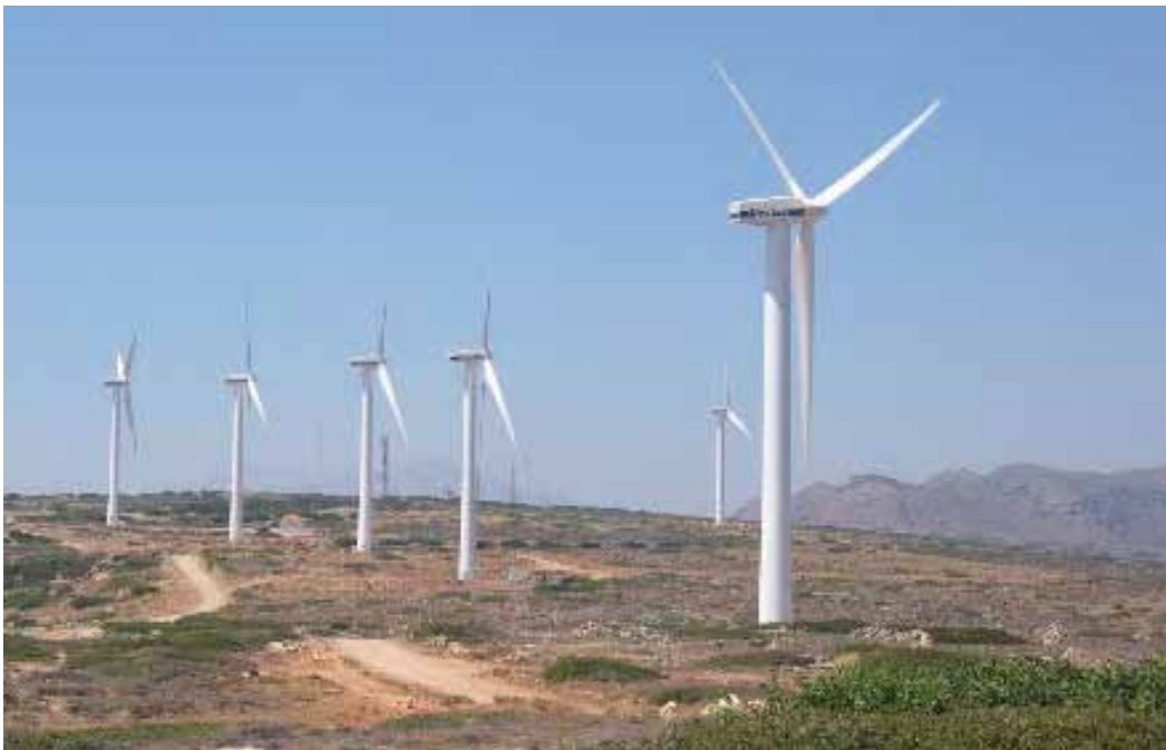
Εικόνα 3.7 Άποψη του Αιολικού Πάρκου στο ακρωτήριο Αη Γιάννης Βρουχά του Νομού Λασιθίου στη Σητεία Κρήτης (6,6 MW)
