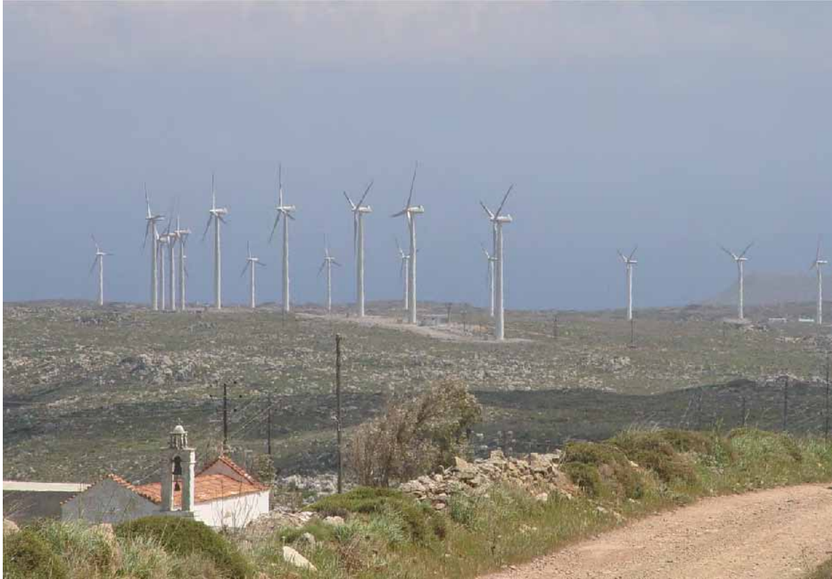
Εικόνα 9.12 Αιολικό Πάρκο Πλατοκερατιάς Μιτάτου
