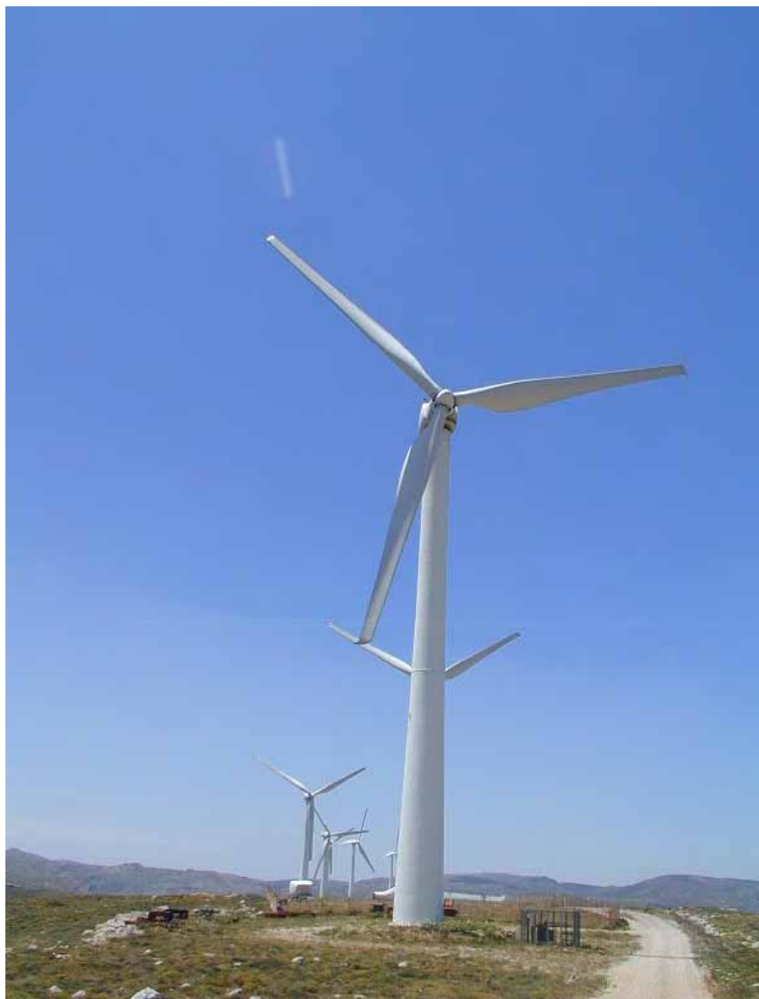
Εικόνα 5.9 Άποψη Αιολικού Πάρκου Χανδρά
