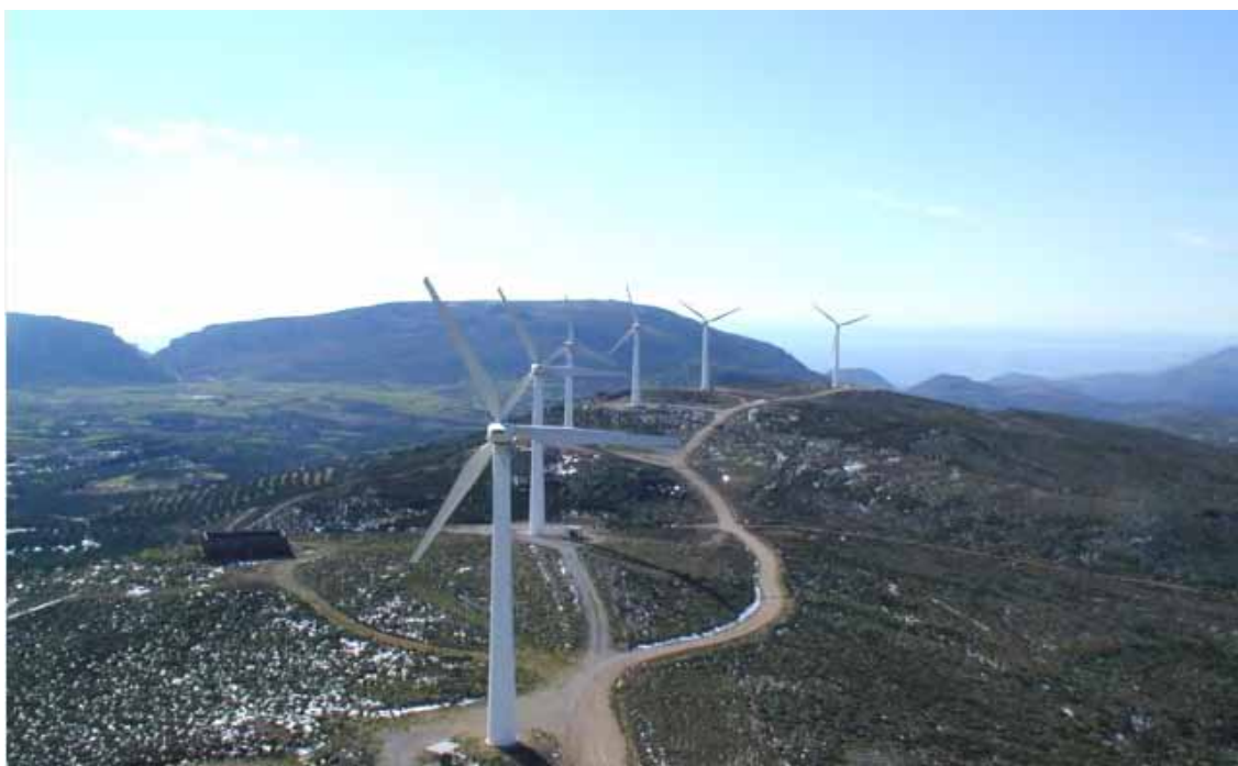
Εικόνα 5.2 Άποψη Αιολικού Πάρκου Χανδρά
