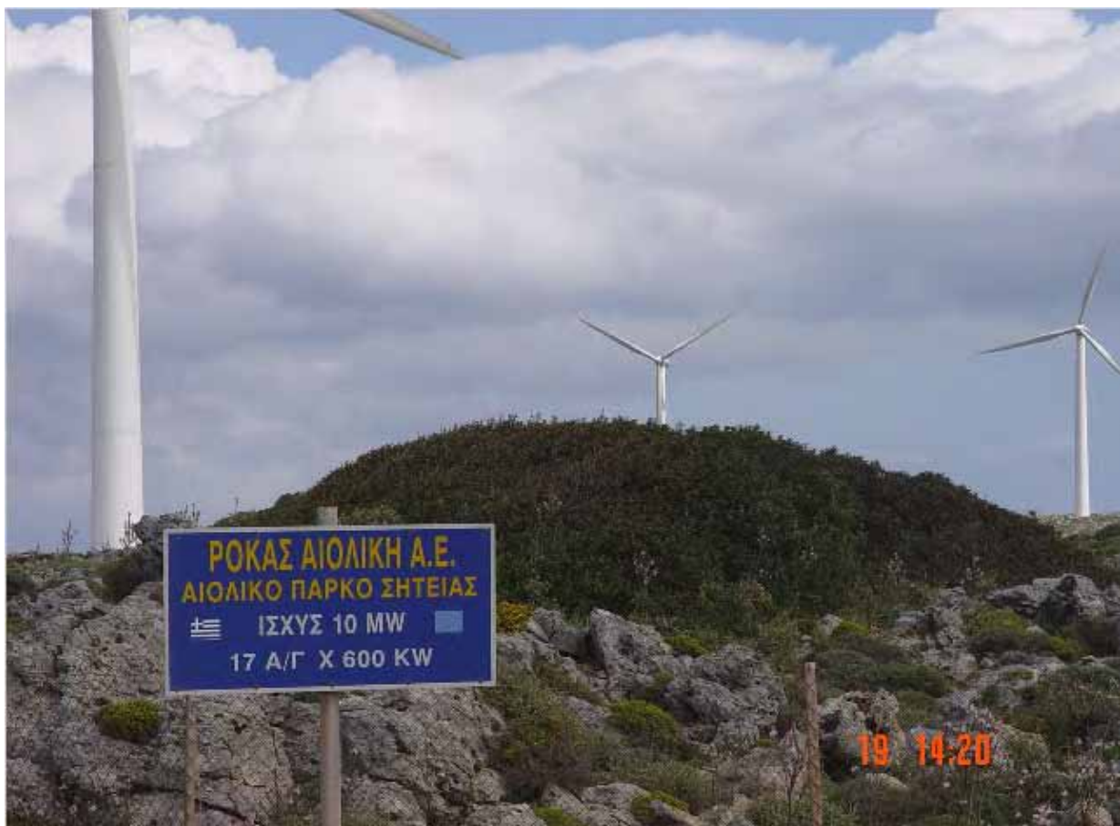
Εικόνα 6.2 Αιολικό Πάρκο Πλατοκερατιάς Μιτάτου
