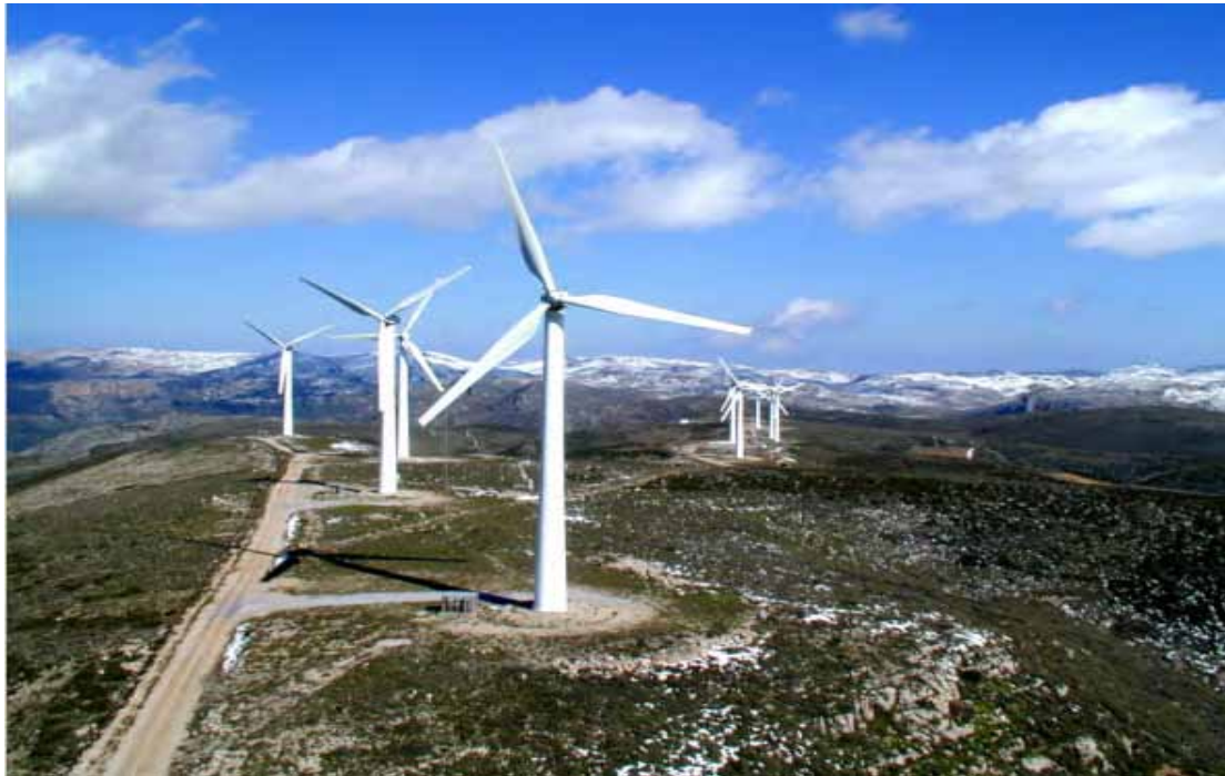
Εικόνα 5.1 Άποψη Αιολικού Πάρκου Χανδρά
