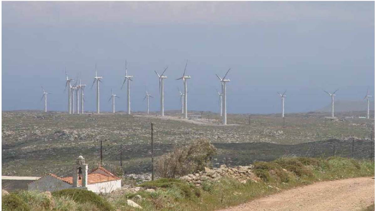
Εικόνα 6.3 Αιολικό Πάρκο Πλατοκερατιάς Μιτάτου
