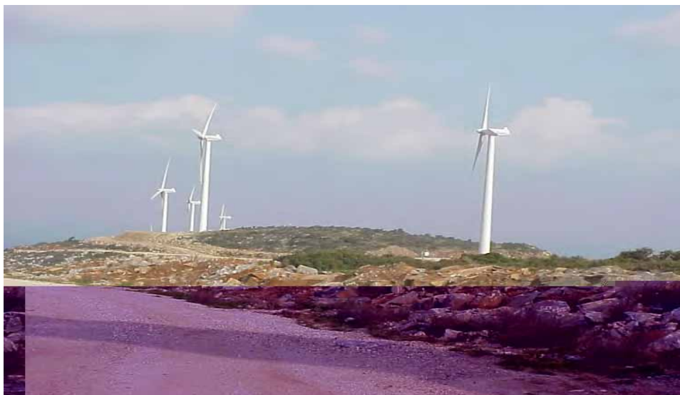
Εικόνα 3.5 Αιολικό Πάρκο στο Ποργάρι Εύβοιας (5,4 MW)
