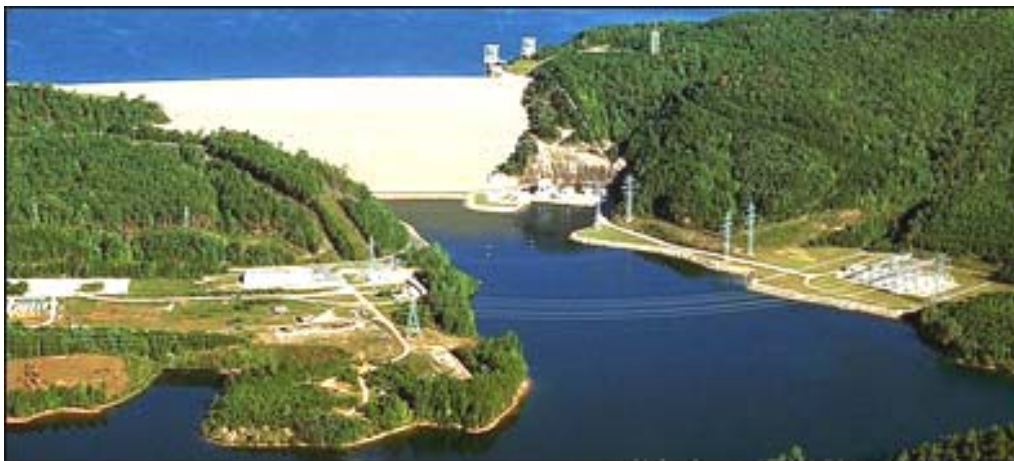
Εικόνα 6.1 Σύστημα αντλιοσταμείωσης ονομαστικής ισχύος 612 MW στο Salem της Νότιας Καρολίνας, Η.Π.Α.
