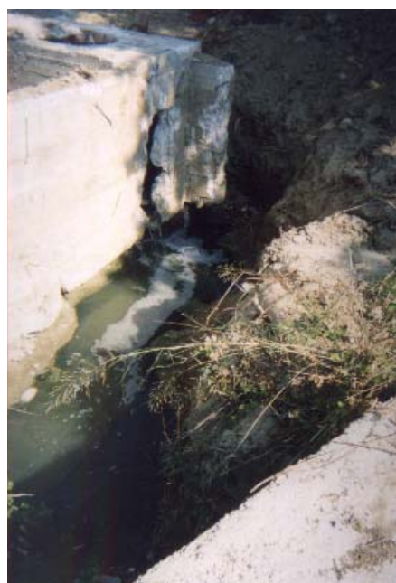
Φωτογραφία 26. Επισκευή του σημείου πρόσβασης των υγρών από το κανάλι συλλογής στο πηγάδι διήθησης.
