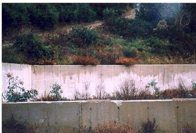
Φωτογραφία 17. Τοιχίο που υψώνεται γύρω από τη λεκάνη εφαρμογής της μονάδας Ζαράκων
