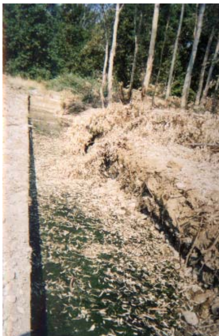
Φωτογραφία 25. Εκσκαφή γύρω από τη λεκάνη για επισκευή και αλλαγή του υποστρώματός της
