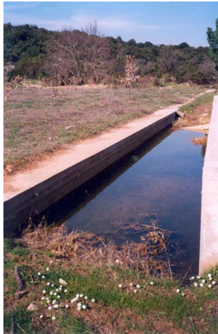
Φωτογραφία 20. Όμβρια ύδατα που λιμνάζουν ανάμεσα στη σηπτική δεξαμενή και το κανάλι διανομής του ΣΥΤ Γαβαλά
