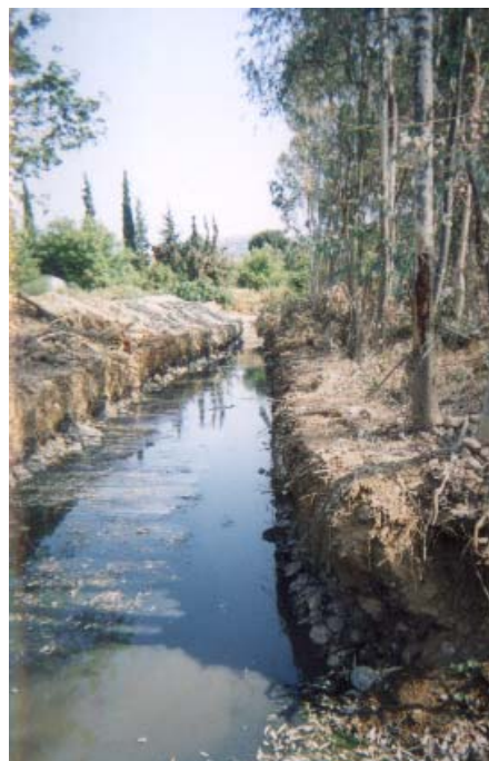
Φωτογραφία 25. Εκσκαφή γύρω από τη λεκάνη για επισκευή και αλλαγή του υποστρώματός της
