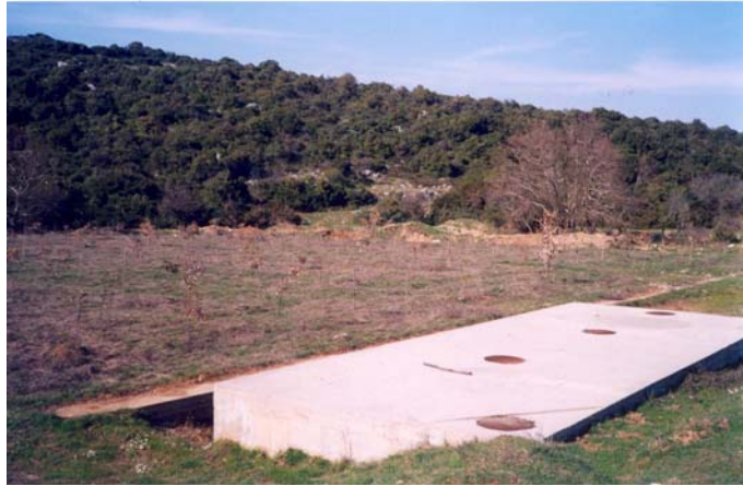
Φωτογραφία 18. Σηπτική δεξαμενή, κανάλι διανομής και λεκάνη εφαρμογής ΣΥΤ κοινότητας Γαβαλά
