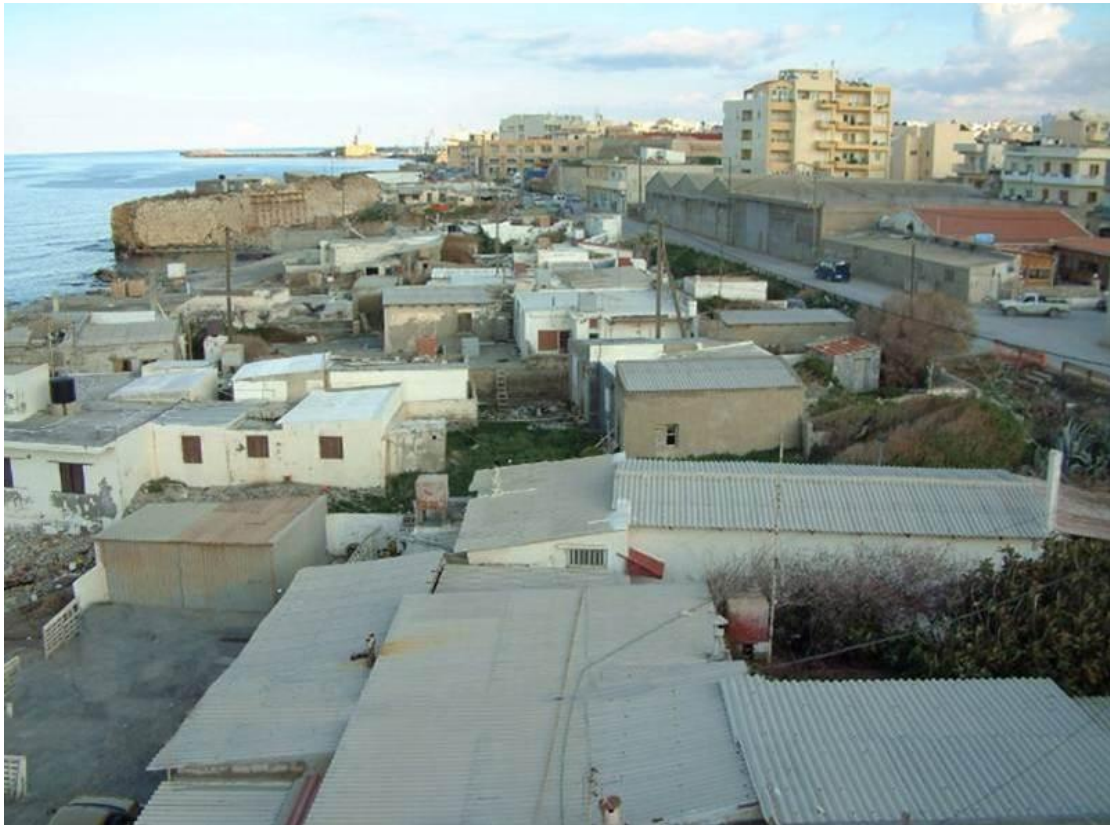
Εικ.19 Περιοχή Καράβολα - Πριν
