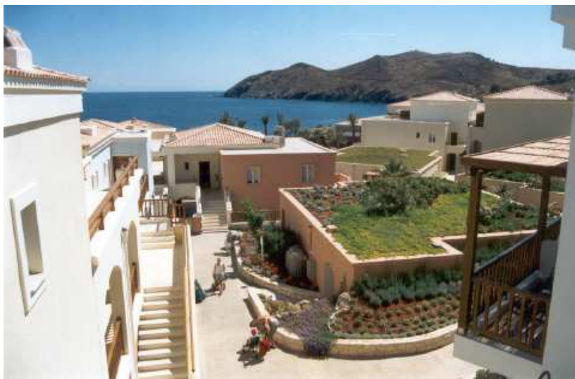
Εικόνα 2. Φυτεμένο δώμα ημιεντατικού τύπου ( Ξενοδοχειακή μονάδα στο Ρέθυμνο )
