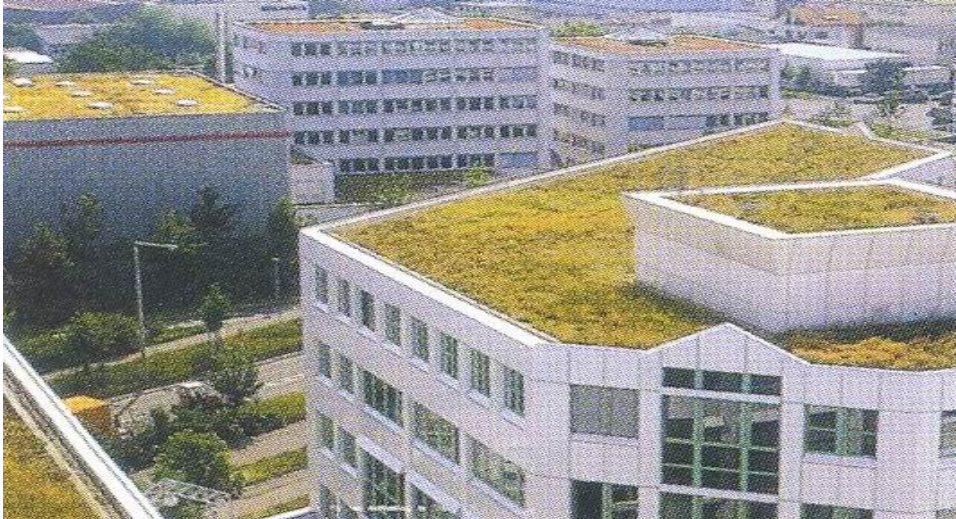
Εικόνα 1. Φυτεμένο δώμα εκτατικού τύπου (Από διαδίκτυο )
