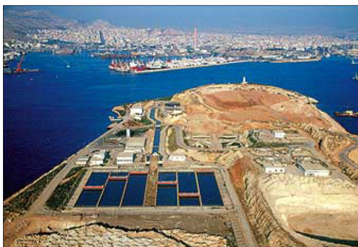
Εικόνα 1.12 Το κέντρο επεξεργασίας λυμάτων στην Ψυτάλλεια (ΕΥΔΑΠ Α.Ε., 2014 α)
