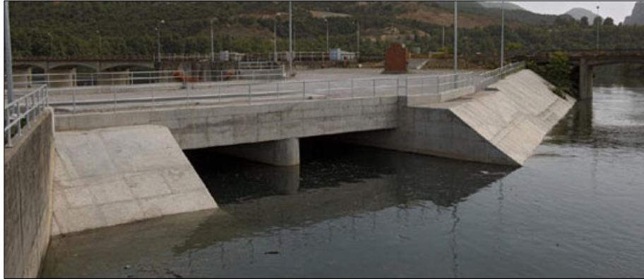
Εικόνα 1.13 Το υδραγωγείο Νάρρες στο Γαλλικό ποταμό (ΕΥΑΘ Α.Ε., 2010 γ)
