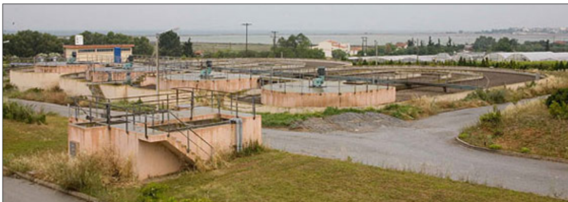
Εικόνα 1.14 Το κέντρο επεξεργασίας λυμάτων της Αίνειας (ΕΥΑΘ Α.Ε., 2010 α)
