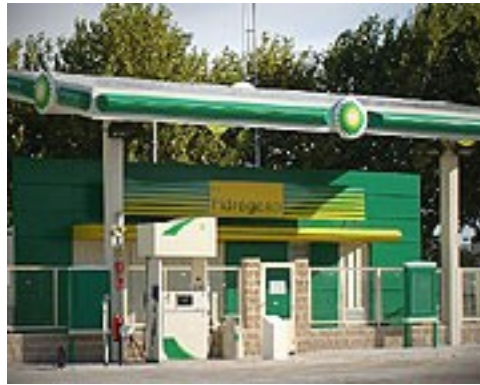
Εικόνα 4.2: Σταθμός διανομής καυσίμου της BP στη Βαρκελώνη της Ισπανίας, για τον ανεφοδιασμό τριών δημόσιων λεωφορείων που κινούνται με κυψέλες καυσίμου.
