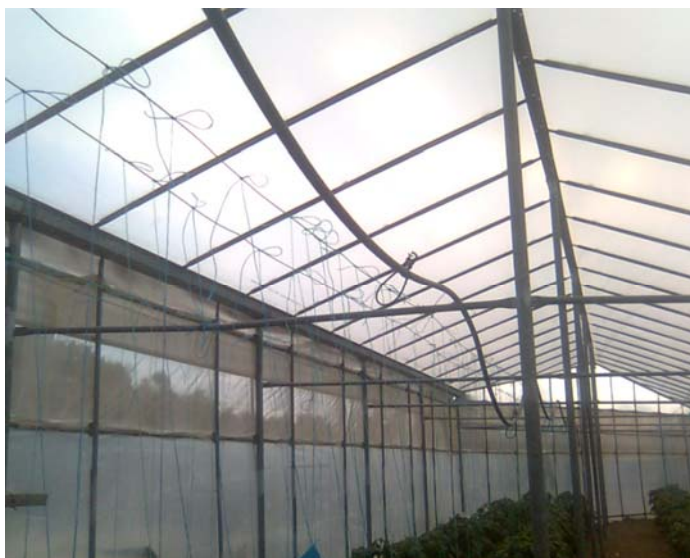
Εικόνα 7.15. Σύστημα υδρονέφωσης
