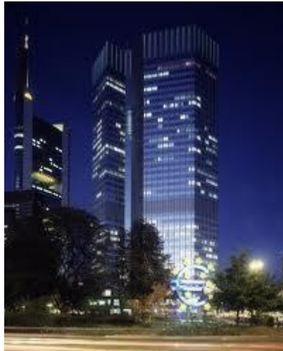
Εικόνα 23: Το κτήριο της Ευρωπαϊκής Κεντρικής Τράπεζας
