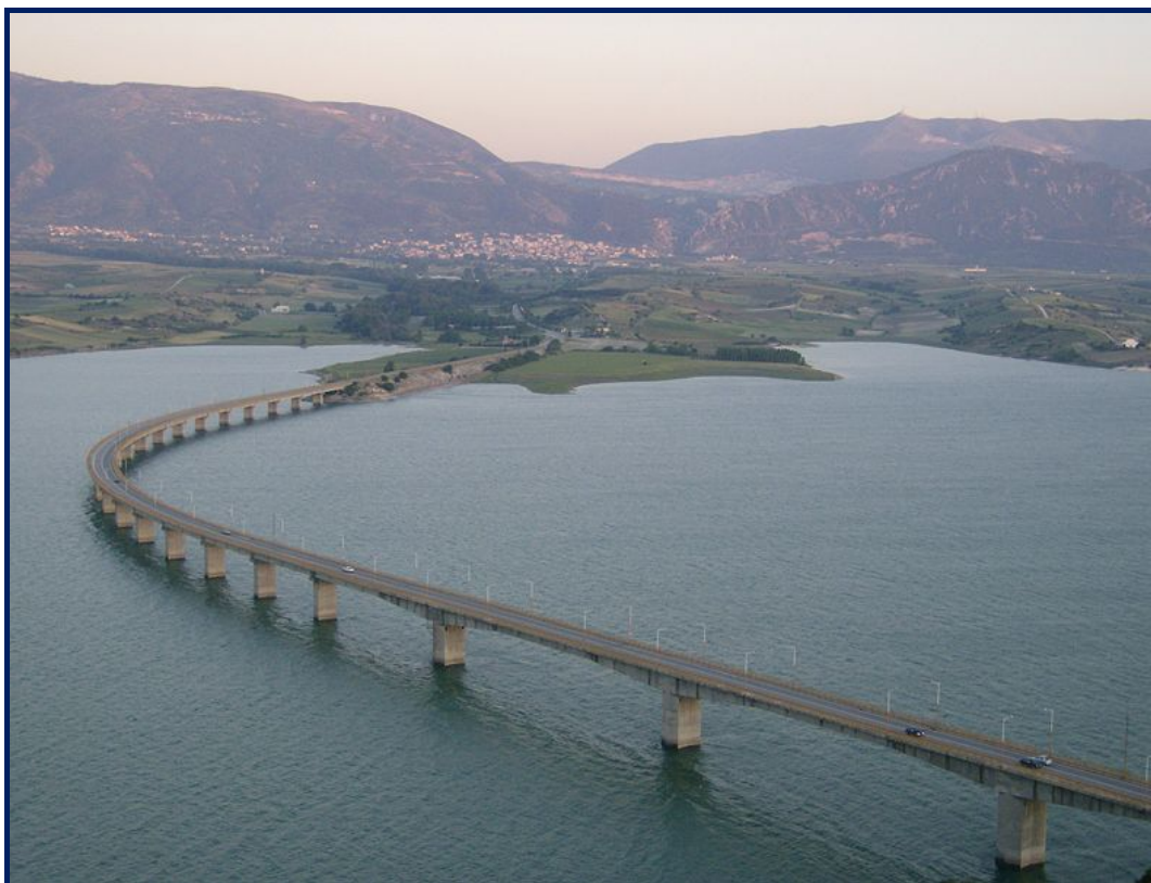
Εικόνα 3.6: Γέφυρα στην τεχνητή λίμνη του Αλιάκμονα
