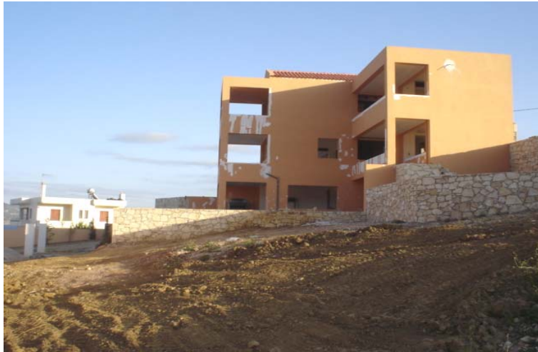
Εικόνα 13. Επιχωμάτωση με φερτό χώμα της επιλογής μας μετά από εκβραχισμό του χώρου.
