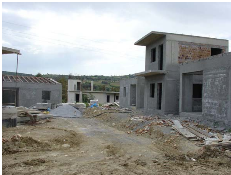
Εικόνα 33333333 . Αποψη του χώρου στο στάδιο των οικοδομικών εργασιών
