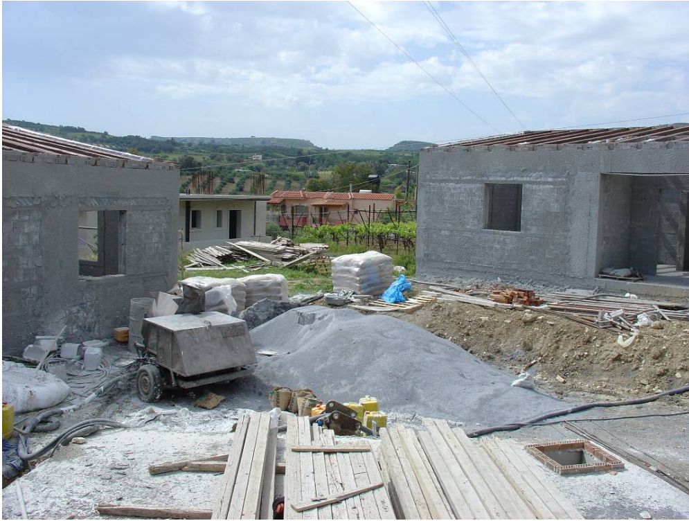
Εικόνα 35353535 , Άποψη του χώρου στο στάδιο των οικοδομικών εργασιών
