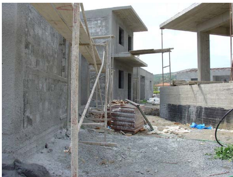
Εικόνα 34343434 . Αποψη του χώρου στο στάδιο των οικοδομικών εργασιών
