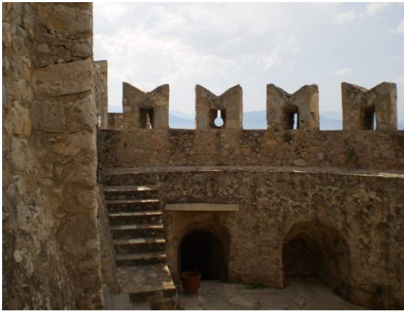
Εικ.26: Μπούρτζι (εσωτερική άποψη)
