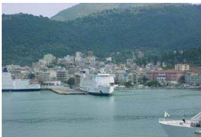
ΦΩΤΟ 4: ΛΙΜΕΝΑΣ ΗΓΟΥΜΕΝΙΤΣΑΣ
