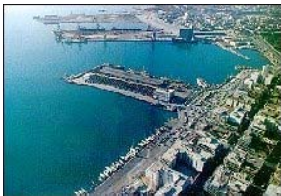
ΦΩΤΟ 5: ΛΙΜΕΝΑΣ ΒΟΛΟΥ
