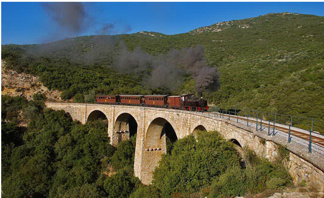
Η ατμάμαξα Tubiz διερχόμενη από την πεντάτοξη λίθινη γέφυρα στο Καλόρρεμα
