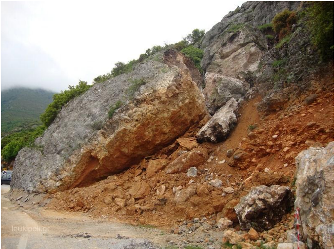
Εικόνα 9: Κατολίσθηση στο Ν. Ρεθύμνου στην επαρχιακή οδό Κρύα Βρύση – Αγία Γαλήνη.
