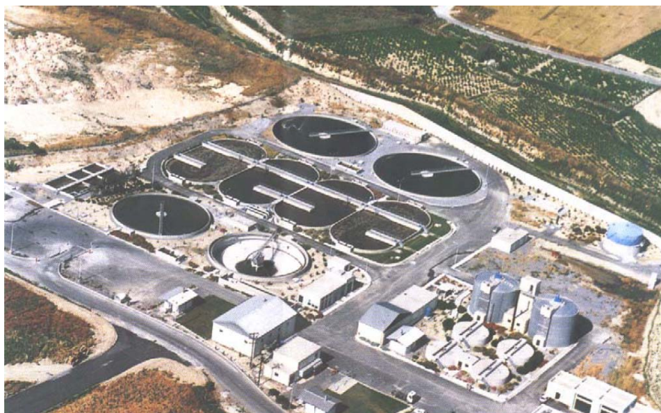
Εικόνα 1.1: Εγκαταστάσεις Βιολογικού Καθαρισμού Πόλης Ηρακλείου Κρήτης.
