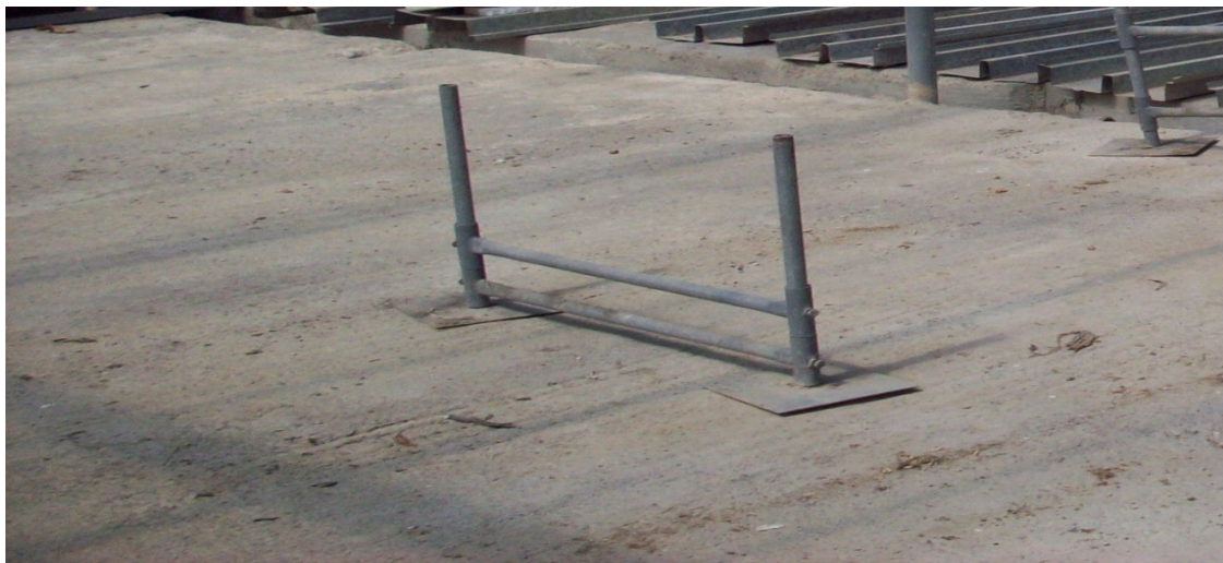
Εικόνα 4.2: Στήριγμα H για την κατασκευή του συστήματος NFT.
