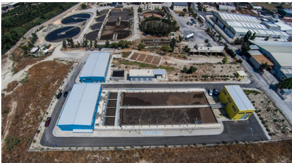
Εικόνα 5: Αεροφωτογραφία εγκαταστάσεων επεξεργασίας λυμάτων του Δήμου Ηρακλείου
