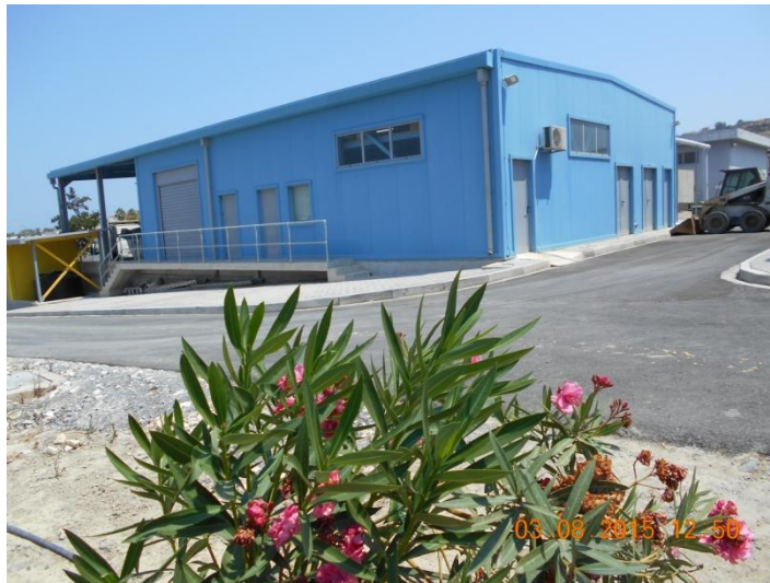
Εικόνα 24: Κτίριο αφυδάτωσης της μονάδας MBR των εγκαταστάσεων επεξεργασίας λυμάτων του Δήμου Ηρακλείου.
