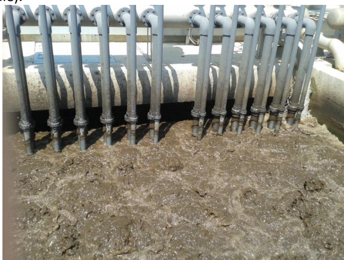
Εικόνα 18: Συστοιχία μεμβρανών (membrane cells) της μονάδας MBR των εγκαταστάσεων επεξεργασίας λυμάτων του Δήμου Ηρακλείου.
