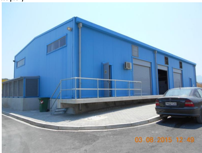
Εικόνα 22: Κτίριο φυσητήρων της μονάδας MBR των εγκαταστάσεων επεξεργασίας λυμάτων του Δήμου Ηρακλείου.
