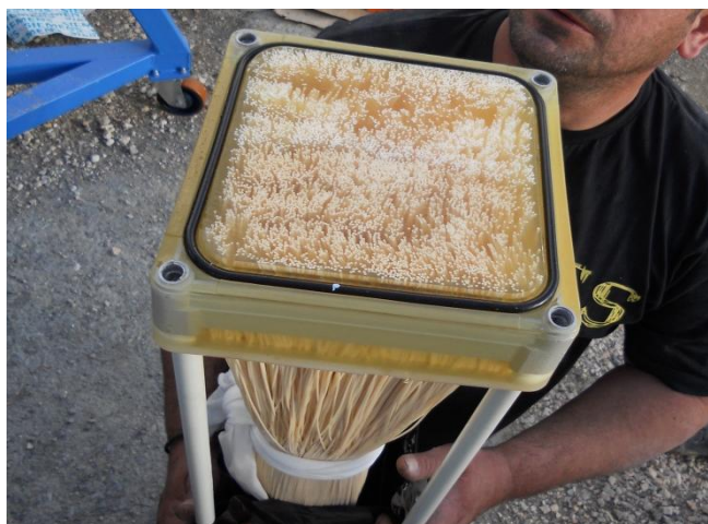
Εικόνα 15:Μεμβράνη μικροδιήθησης κοίλων ινών της μονάδας MBR των εγκαταστάσεων επεξεργασίας λυμάτων του Δήμου Ηρακλείου
