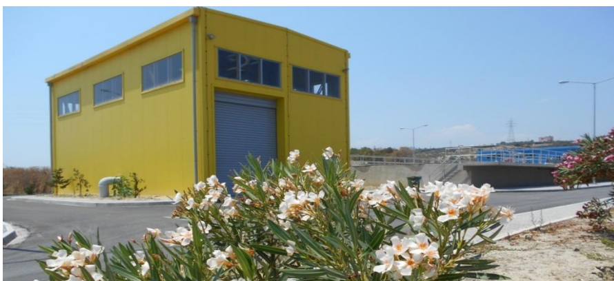
Εικόνα 8: Μονάδα λεπτοκοσκίνισης της μονάδας MBR των εγκαταστάσεων επεξεργασίας λυμάτων του Δήμου Ηρακλείου
