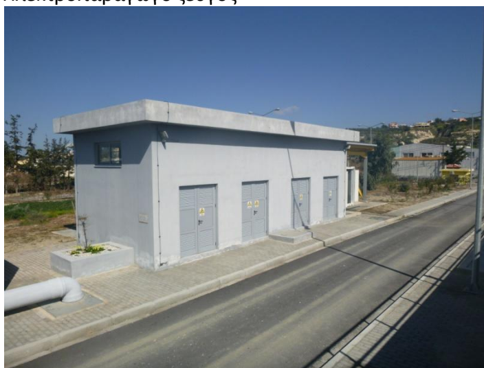
Εικόνα 27:Υποσταθμός μέσης τάσης της μονάδας MBR των εγκαταστάσεων επεξεργασίας λυμάτων του Δήμου Ηρακλείου.
