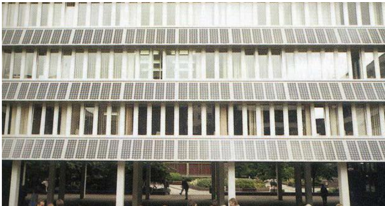
Εικόνα 3.2 Πρώτο κτίριο της Βρετανίας με φωτοβολταϊκή επένδυση, ένα σύστημα 40 kWp εγκαταστάθηκε το 1995 στην πρόσοψη του ένα ανακαινισμένο κέντρο πληροφορικής στο Πανεπιστήμιο του Northumbria στο Newcastle.
