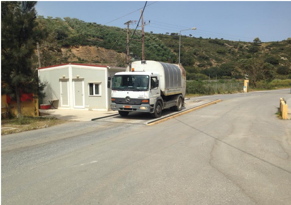
Εικόνα 5.6: Είσοδος και γεφυροπλάστιγγα του ΧΥΤΑ
