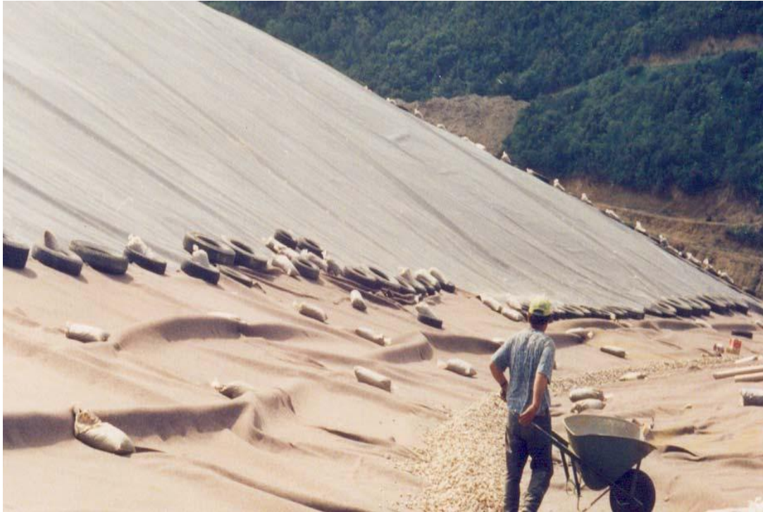
Εικόνα 5.14: Εργασίες στεγάνωσης του χώρου.
