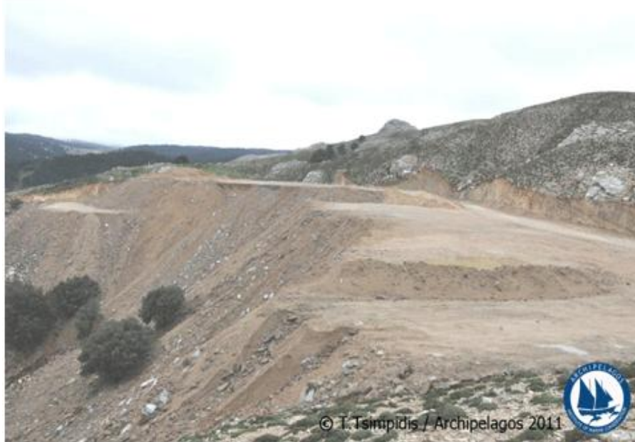
Εικόνα 22: Εργασίες οδοποιίας προς το αιολικό πάρκο
