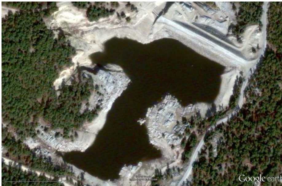
Εικόνα 6: Δορυφορική εικόνα του Φράγματος Πέζι από το Google Earth
