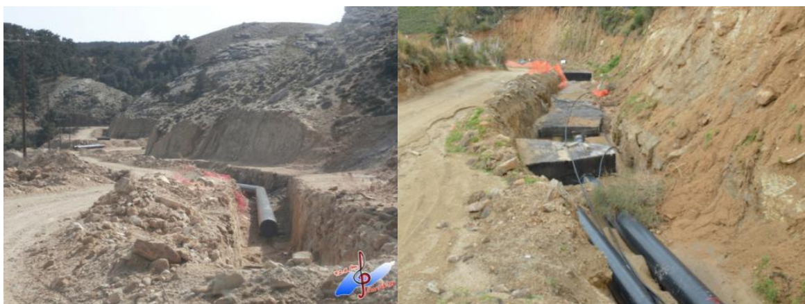
Εικόνα 14: εργασίες κατασκευής και τοποθέτησης αγωγών του έργου
