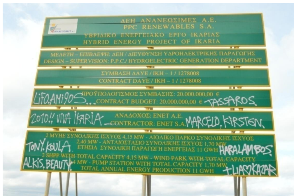
Εικόνα 12: Πληροφοριακή πινακίδα κατασκευής του Έργου
