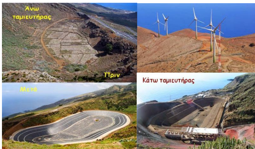
Εικόνα 9: Φωτό από τμήματα κατασκευής του Έργου
