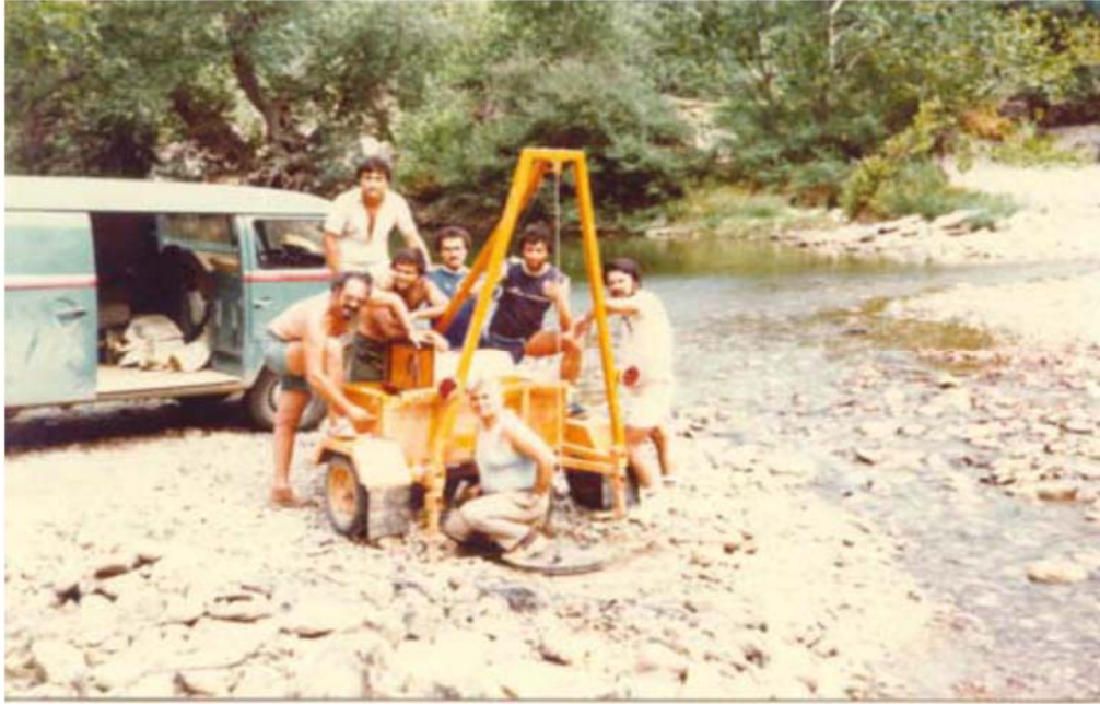
Σχήμα 3.21 Γεωφυσικό συνεργείο του Τομέα Γεωφυσικής του Πανεπιστημίου Αθηνών ενώ μεταφέρει τον μηχανισμό του πίπτοντος βάρους στη προβλεπόμενη θέση παραγωγής σεισμικής ενέργειας (1995, σεισμική έρευνα στο φράγμα Χαβρία, Χαλκιδική) [Ιωάννης Φ. Λούης, 2004].
