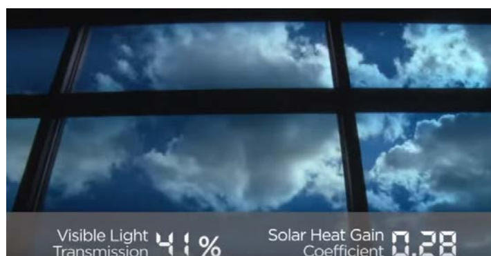
Εικόνα 2: Λειτουργία Ηλεκτροχρωμικού Παραθύρου της SageGlass (5)
