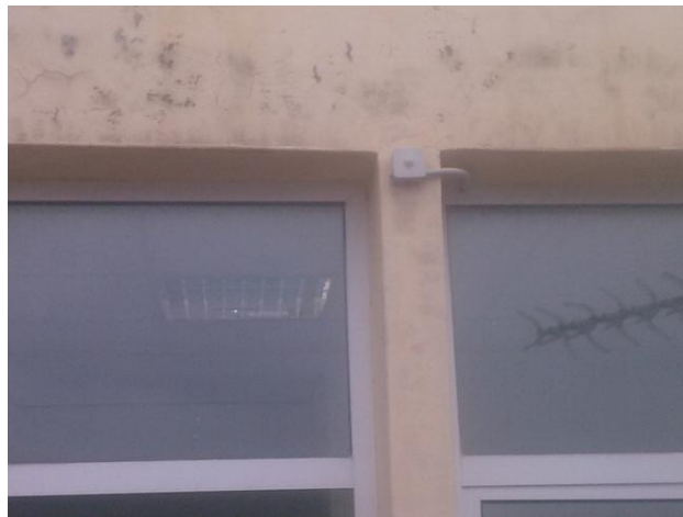
Εικόνα 9.17: Τοποθέτηση εξωτερικού αισθητήρα φωτεινότητας.
