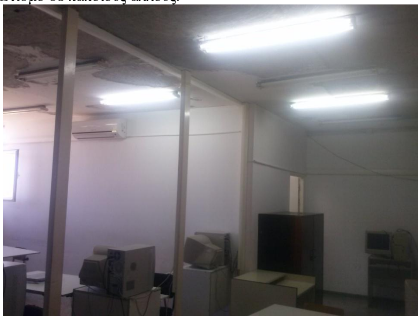
Εικόνα 6.6: Διαρρύθμιση χώρου με γυψοσανίδα.
