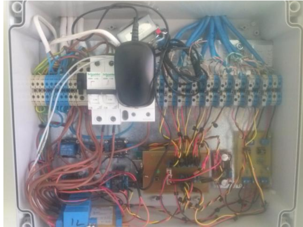
Εικόνα 9.19: Τοποθέτηση μονάδας ελέγχου, περιφερειακών και ασφαλιστικών μέσων.
