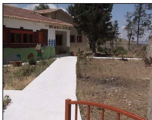
Φωτ. 38: Ο κύριος χώρος της εισόδου
