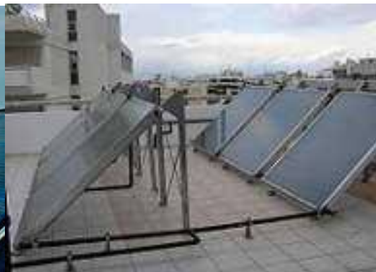
Σε οριζόντια στέγη
