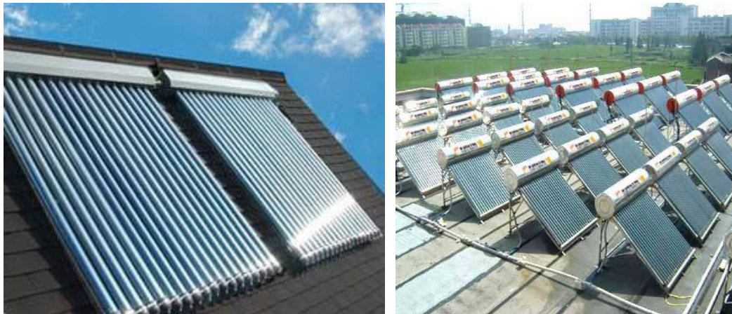
Σχήμα 3.15. Ηλιακοί συλλέκτες κενού
