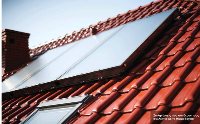
Σε κεκλιμένη στέγη
