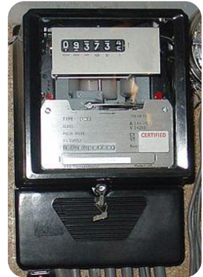
Εικόνα 2.1: Ηλεκτρομηχανικός Μετρητής Επαγωγής Τριών Φάσεων
