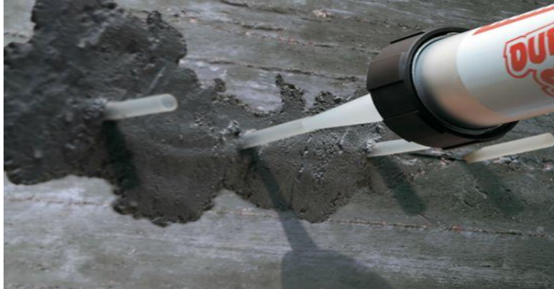
Σχήμα 1.14 Ένεση με εποξική ρητίνη.
