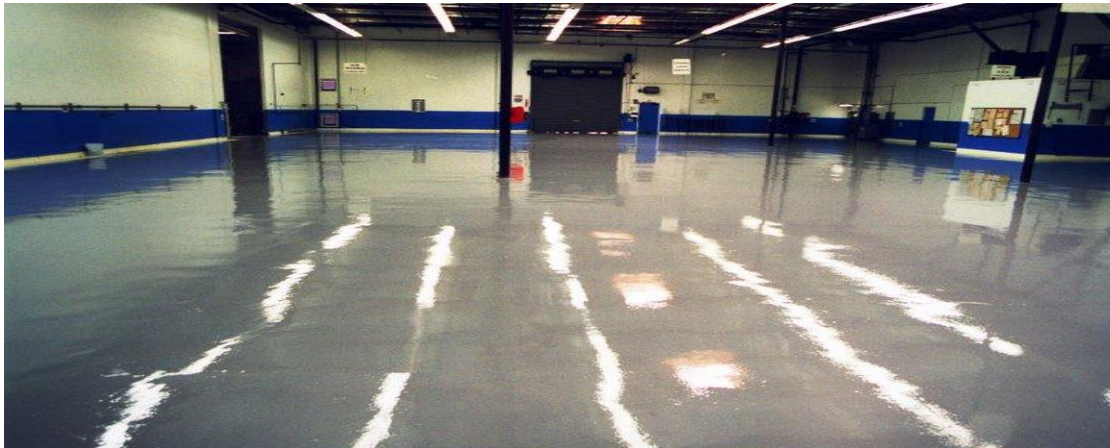
Σχήμα 1.15 Πάτωμα εμβαπτισμένο με εποξική ρητίνη
