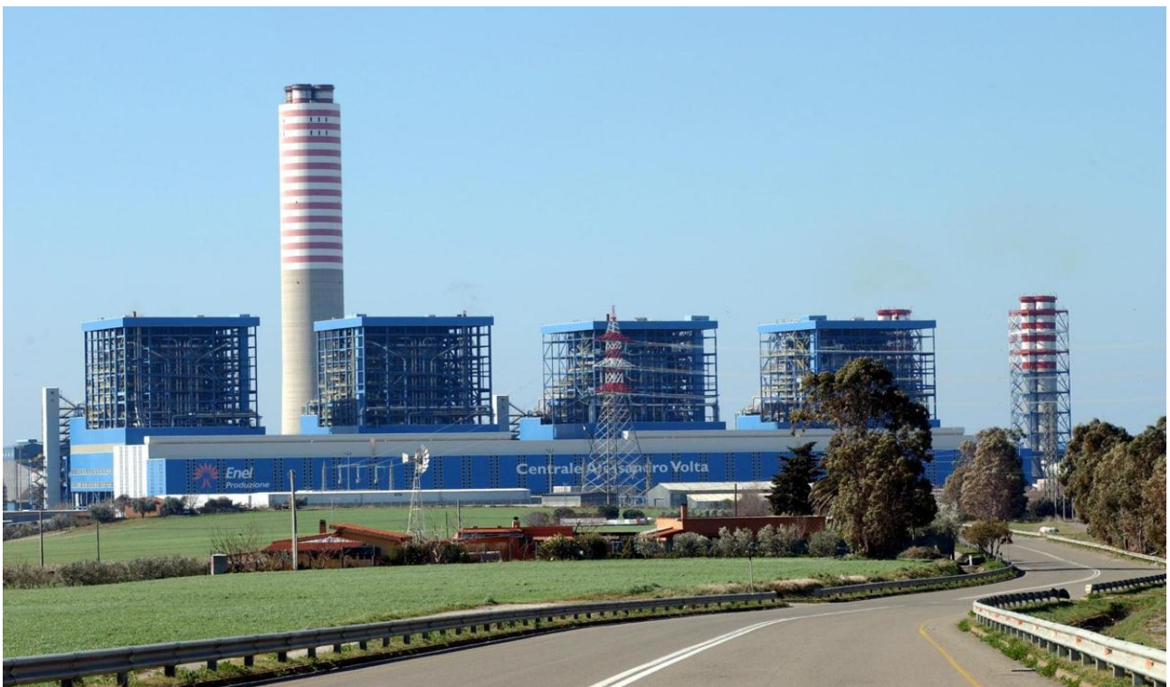
Σχήμα 3.1.2 Σταθμός παραγωγής ηλεκτρικής ενέργειας coal and gas της Enel στο montalto di castro, Ιταλία.
