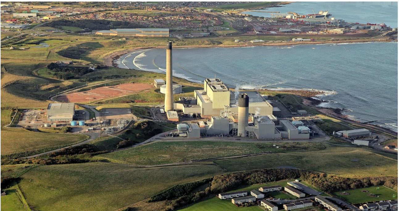
Σχήμα 3.1.7 Σταθμός παραγωγής ηλεκτρικής ενέργειας coal and gas της Centrica plc στο Peterhead, Σκωτία.
