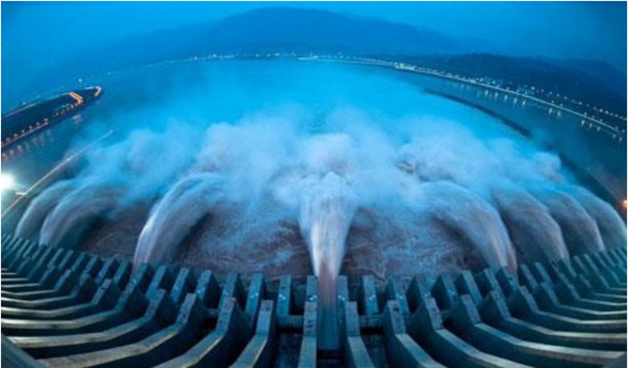
Σχήμα 1.3.9.1: Υδροηλεκτρικός Σταθμός στη Λετονία.
