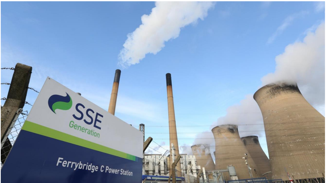
Σχήμα 3.1.5 Σταθμός παραγωγής ηλεκτρικής ενέργειας coal and gas/nuclear της Sse στο FerryBridge, Ηνωμένο Βασίλειο .
