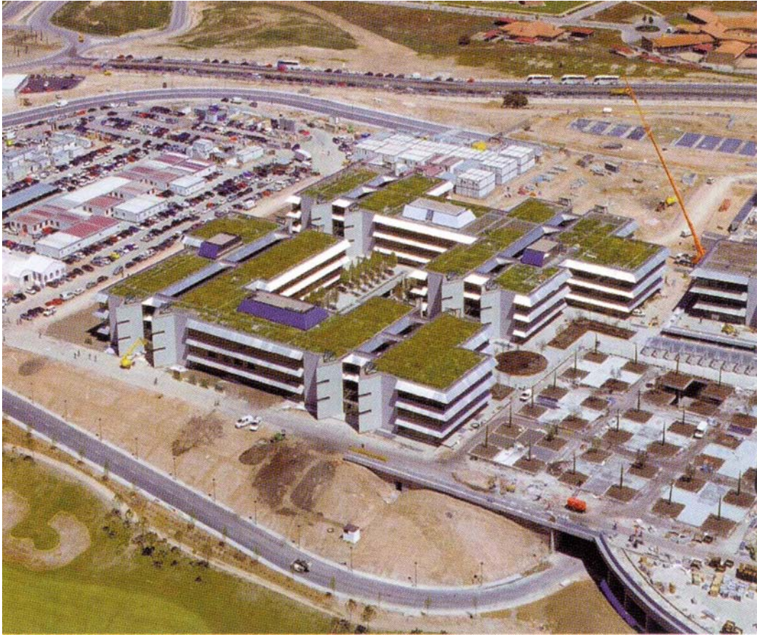
Η μεγαλύτερη πράσινη στέγη στην Μαδρίτη, <<Banco de Santander>>
