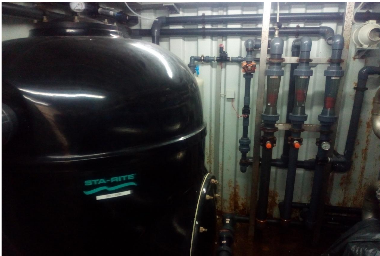
Εικόνα 7.4.1 Δολομιτικό φίλτρο εντός μεγάλης αφαλάτωσης
