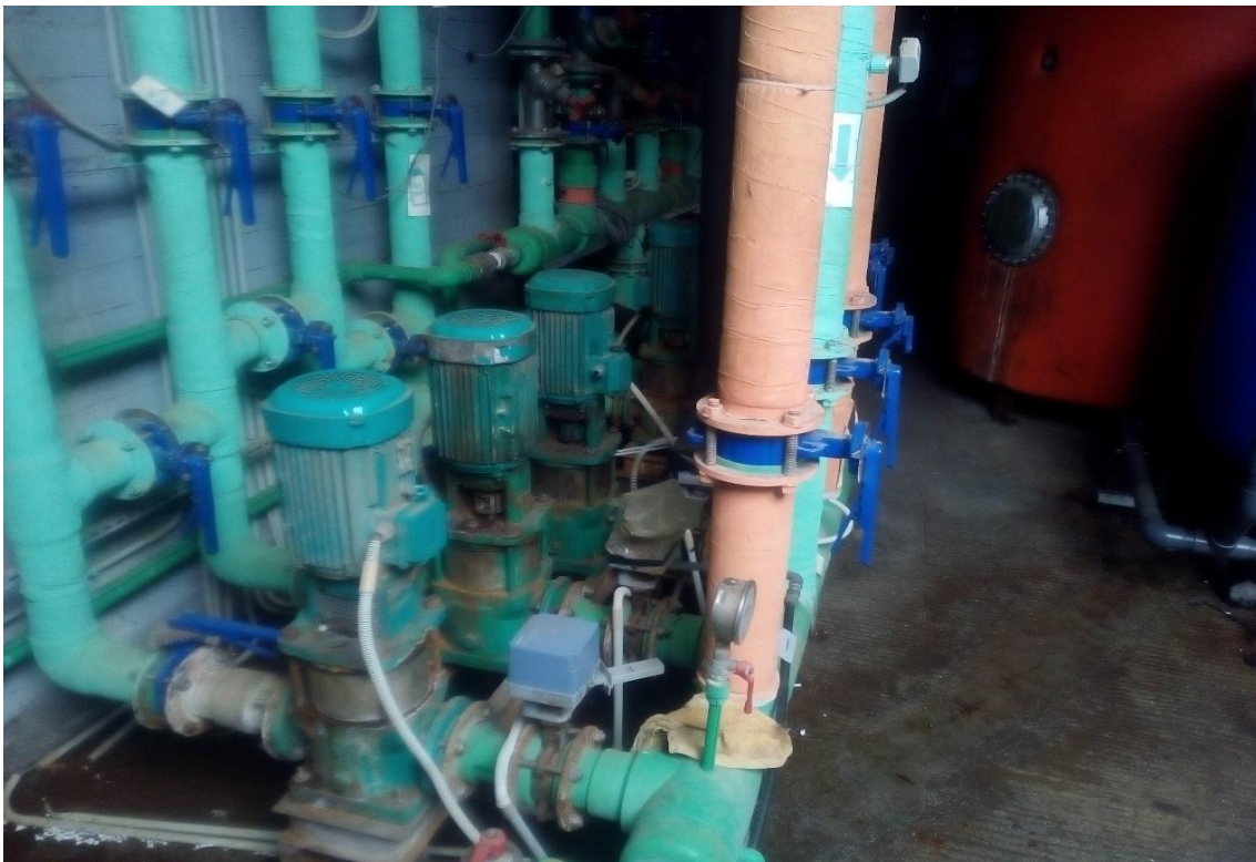
Εικόνα 6.1.6 Πιεστικό συγκρότημα ηλιακών πεδίων
