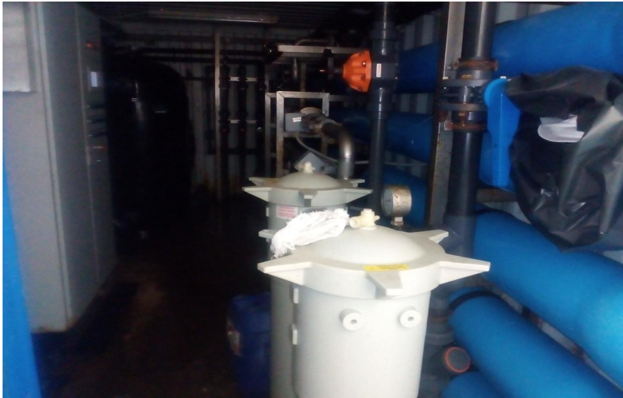
Εικόνα 7.4.2 Σακόφιλτρα μεγάλης αφαλάτωσης
