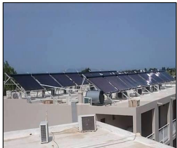
Εικόνα 2.4 Σύγχρονη εγκατάσταση ηλιοθερμίας στην Κω
