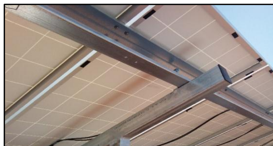
Εικόνα 5.3 Πίσω μέρος σταθερής βάσης φωτοβολταϊκών πάνελ
