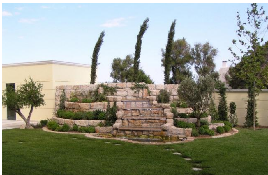
Εικόνα 3: Επένδυση κατασκευής καταρράκτη και παρτεριών με φυσική πέτρα.
