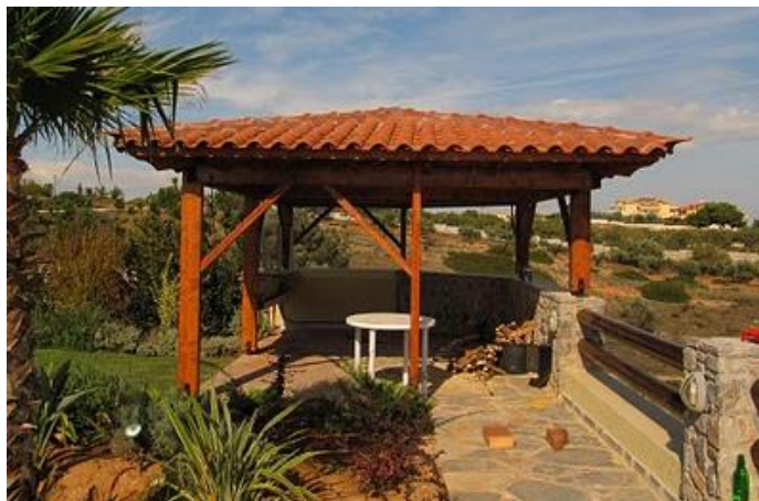
Εικόνα 10: Κατασκευή κιοσκιού με σκεπή από κεραμίδι (ksilokosmos.blogspot.com).
