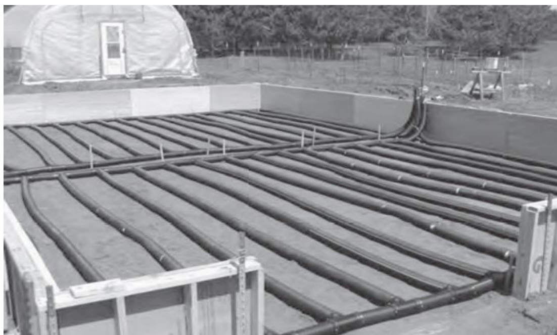
Εικόνα 7. Σύστημα ενδοδαπέδιας θέρμανσης σε θερμοκήπιο.
