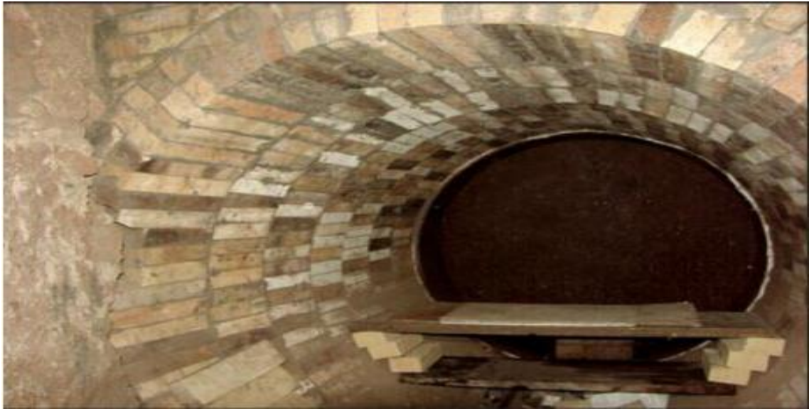
Εικόνα 27 Παρουσίαση ενός δωματίου θέρμανσης κατασκευασμένο με μονωτικά πυρίμαχα
