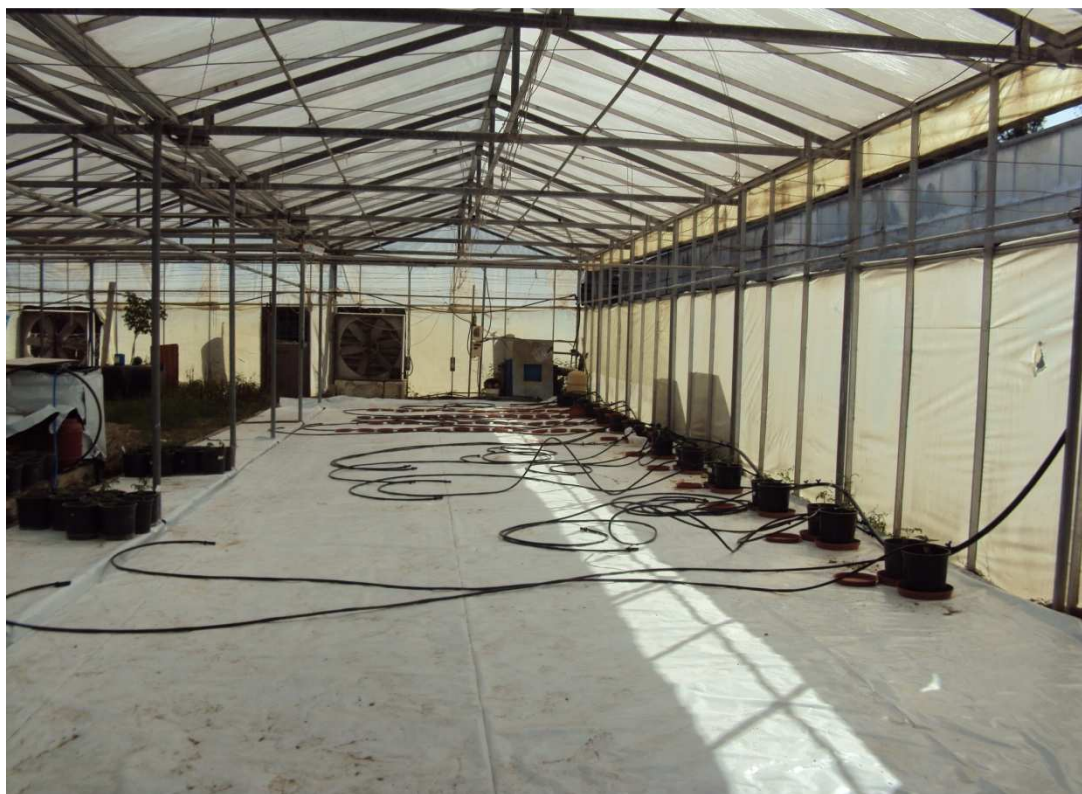
Εικόνα 4.10: Εγκατάσταση αρδευτικού δικτύου.
