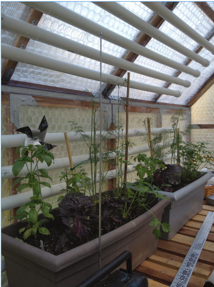
Εικόνα 3.1: Υλικά αλλαγής φάσης μορφής σωλήνα εφαρμοσμένα σε πραγματικό θερμοκήπιο
