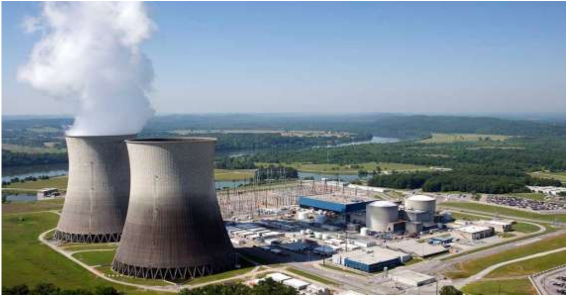
Εικόνα 1: Πυρηνική εγκατάσταση παραγωγής ηλεκτρικού ρεύματος.
