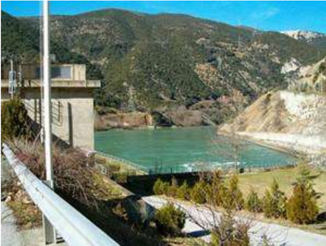
Εικόνα 30: Φράγμα Σφηκιά στον Αλιάκμονα
