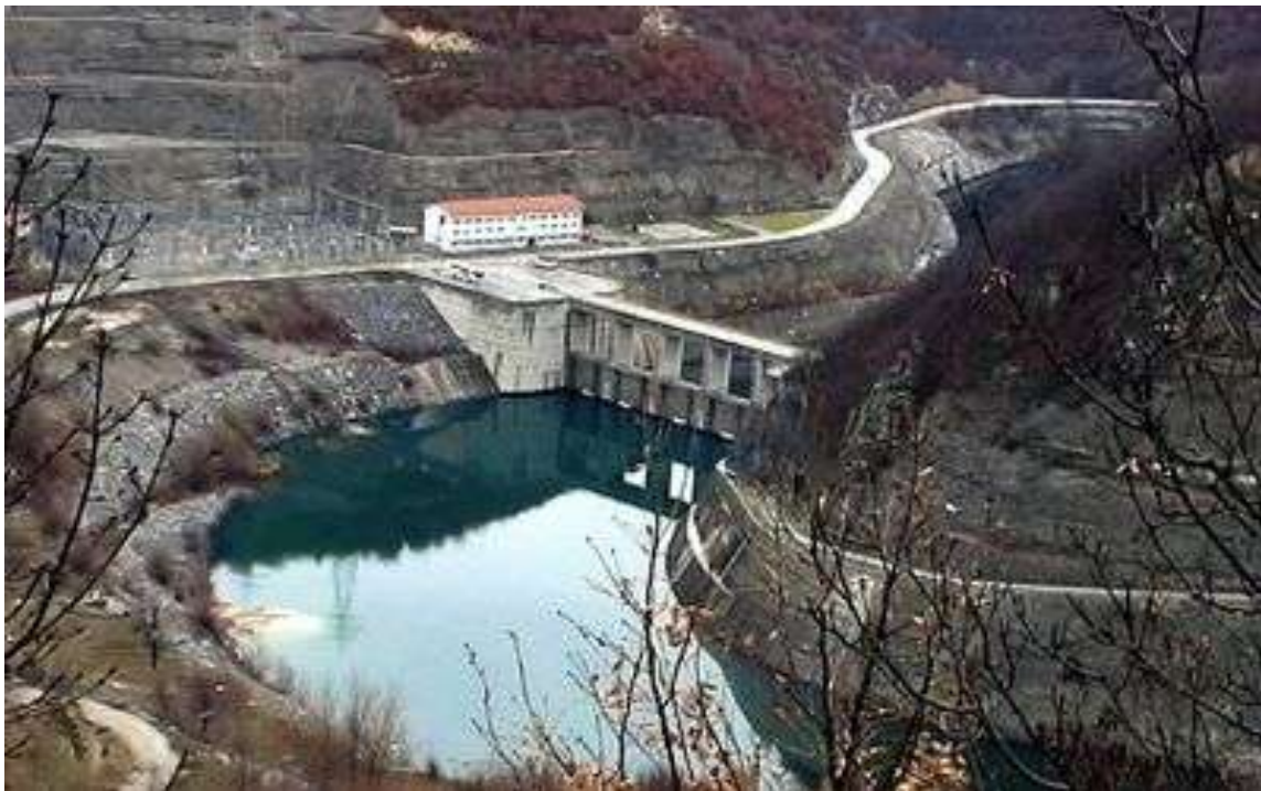
Εικόνα 29: Το φράγμα του Θησαυρού στο Νέστο
